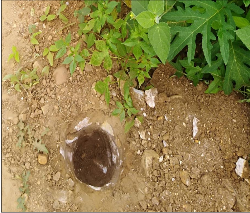
Fotografía 7: Perforaciones de 1.20m para fines de excavación
