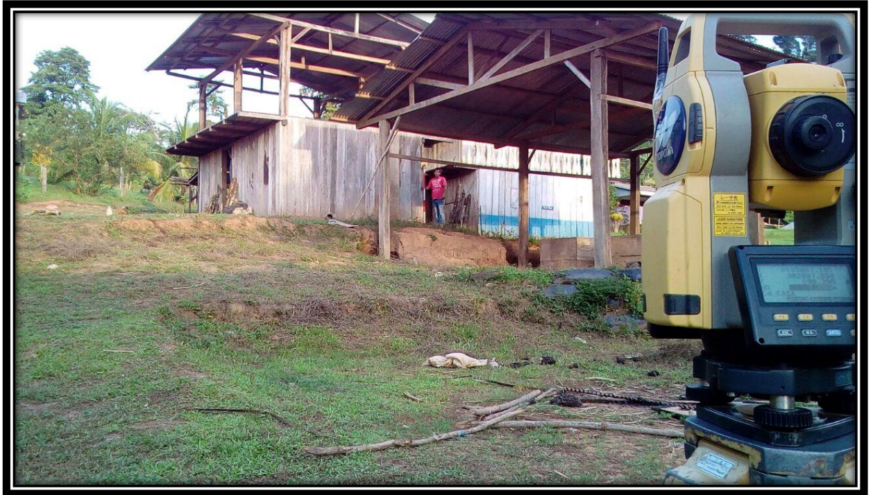
FOTO N°04: VISTA PANORAMICA DEL LEVANTAMIENTO
