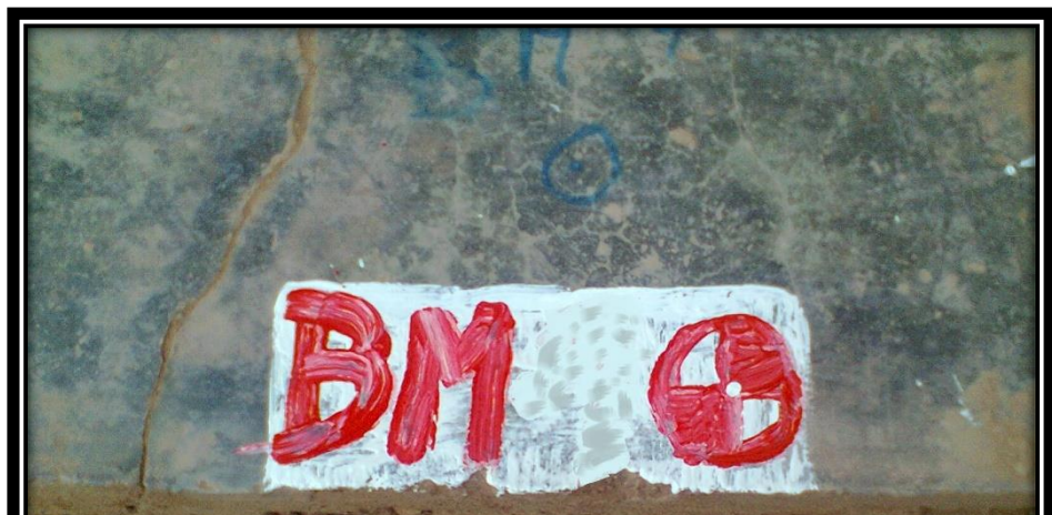
FOTO 01: COLOCACION DEL BM – MODELO TIPICO DE BMs.
