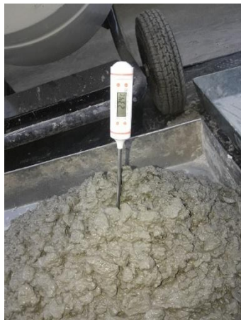
Figura 9. Temperatura al concreto fresco.
