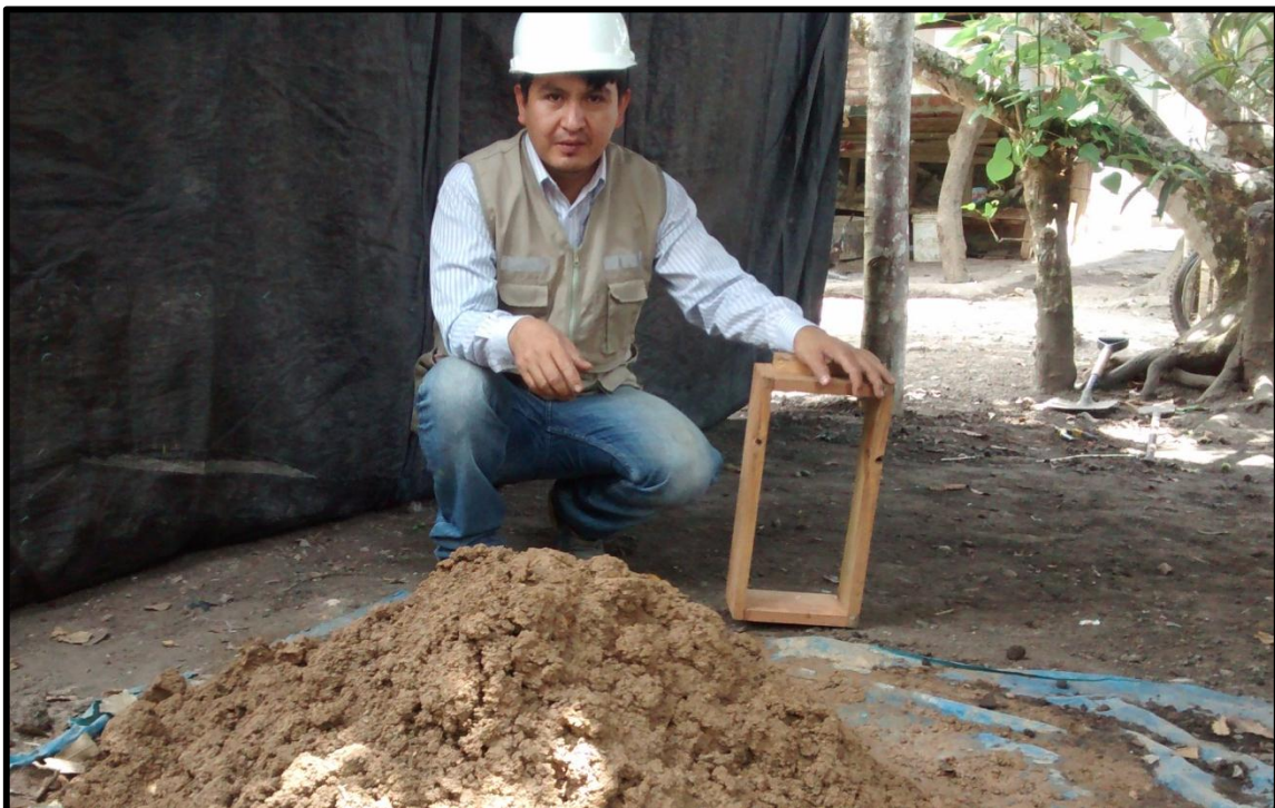
Figura N° 34: Dormido del suelo para la fabricación de adobes.
