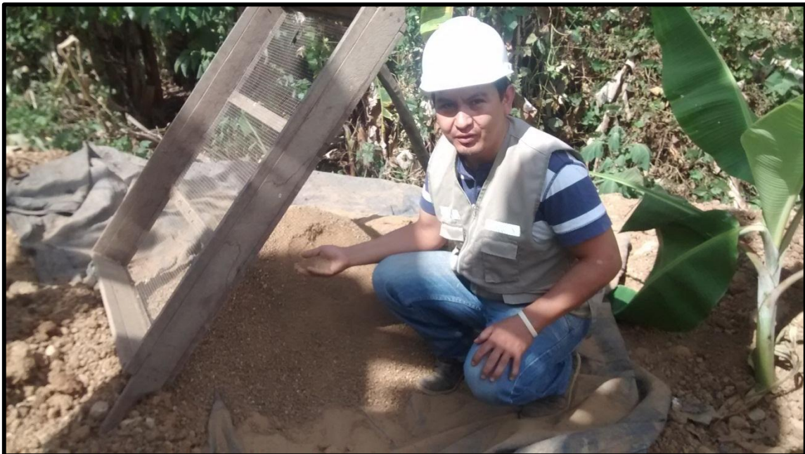
Figura N° 32: Zarandeado del suelo para fabricar los adobes.
