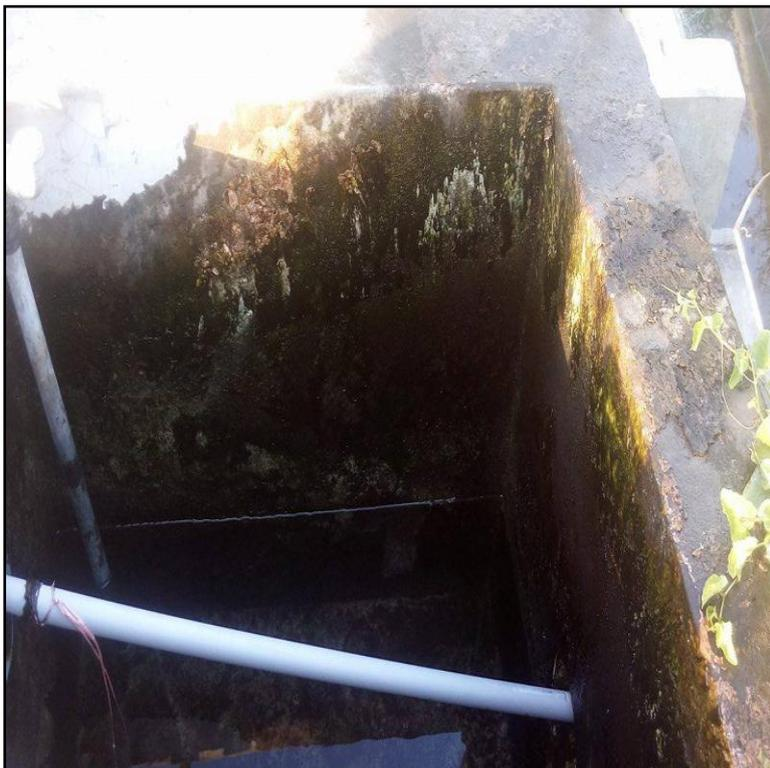
**Imagen N° 02:** Poza disipadora que recibe la extracción de agua del pozo tubular.
