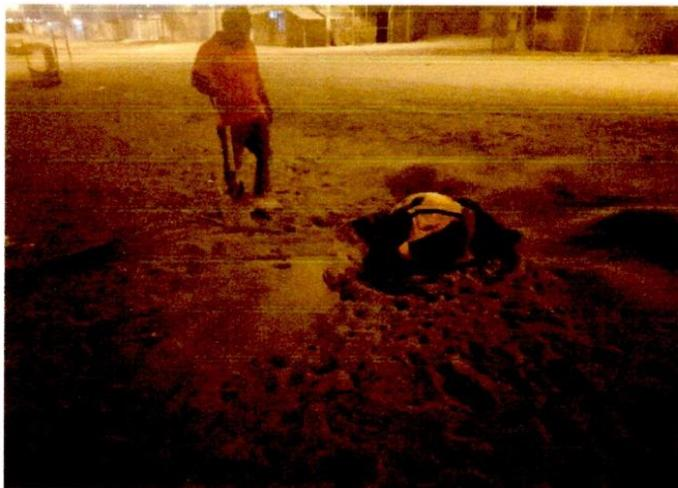
En la presente imagen se aprecia las aperturas de las calicatas para la toma de muestra.
