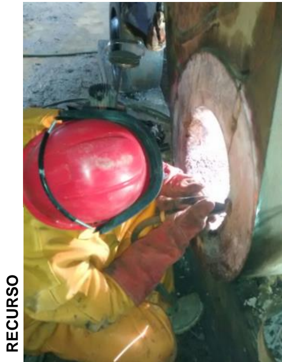
IMAGEN 9: Soldador realizando el relleno de las partes a reparar
