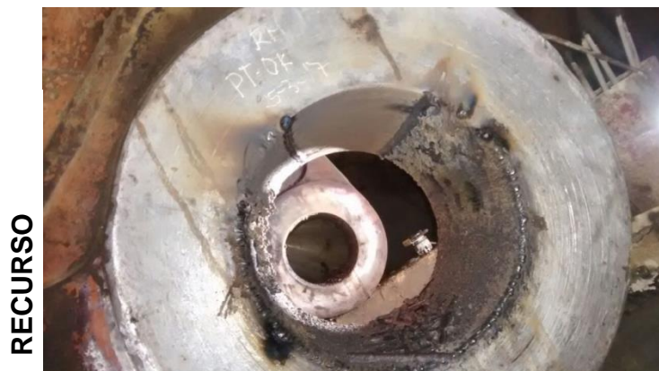
IMAGEN 10: Rellenado del alojamiento con electrodo tenacito 110
