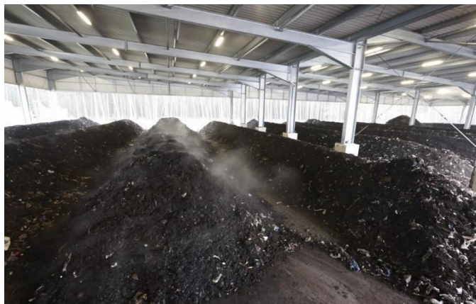
Figura 38. Apilamiento, Planta de tratamiento de “RSU” con producción de energías renovables- empresa COGERSA, Fuente: http://www.cogersa.es/metaspacesportal/14498/19176 edición: propia 2017
