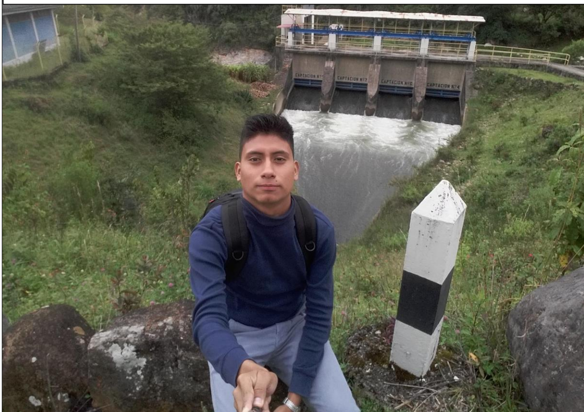
Bocatoma que capta las aguas del río Chotano para luego ser trasvasadas por el túnel que lleva el mismo nombre (túnel de trasvase Chotano).
