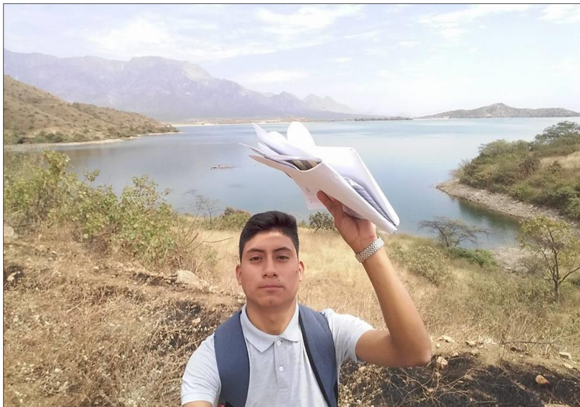
Reservorio "Tinajones": Construido entre los años de 1963 – 1968, cuenta con una capacidad de almacenamiento de 320 millones de m 3 y está constituido por un dique principal de 2440.00 m de longitud y 40.00 m de altura, y por 3 diques secundarios.
