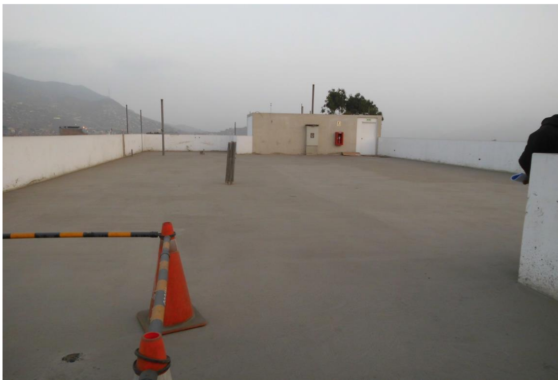
Anexo 18: Fotografía de la azotea del edificio del Pabellon “D” de la UCV-Sede Lima – Este. Fuente: Elaboración Propia. Fecha 02 de Julio de 2018.
