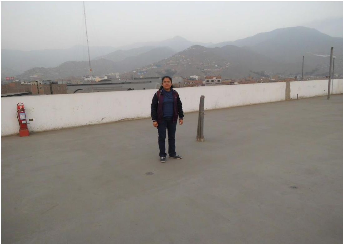
Anexo 20: Fotografía de la azotea del edificio del Pabellón “D” de la UCV-Sede Lima – Este. Fuente: Elaboración Propia. Fecha 02 de Julio de 2018.
