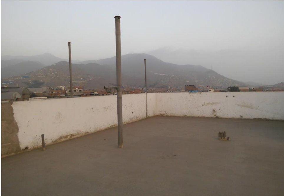
Figura 5. Azotea actual, vista de tuberías de desagüe y sumideros.
