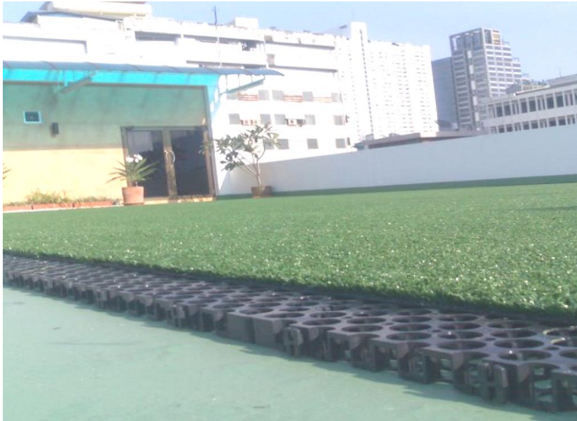
Figura 15. Celdas de infiltración Atlantis.
