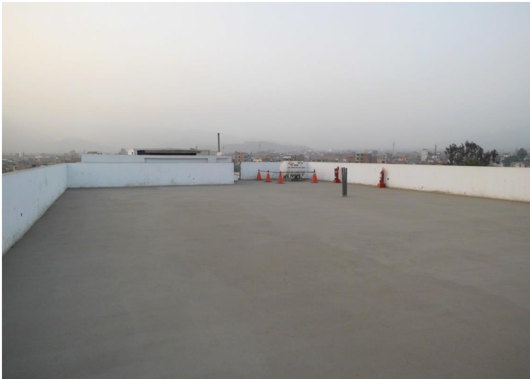
Anexo 17: Fotografía de la azotea del edificio del Pabellon “D” de la UCV-Sede Lima – Este. Fuente: Elaboración Propia. Fecha 02 de Julio de 2018.
