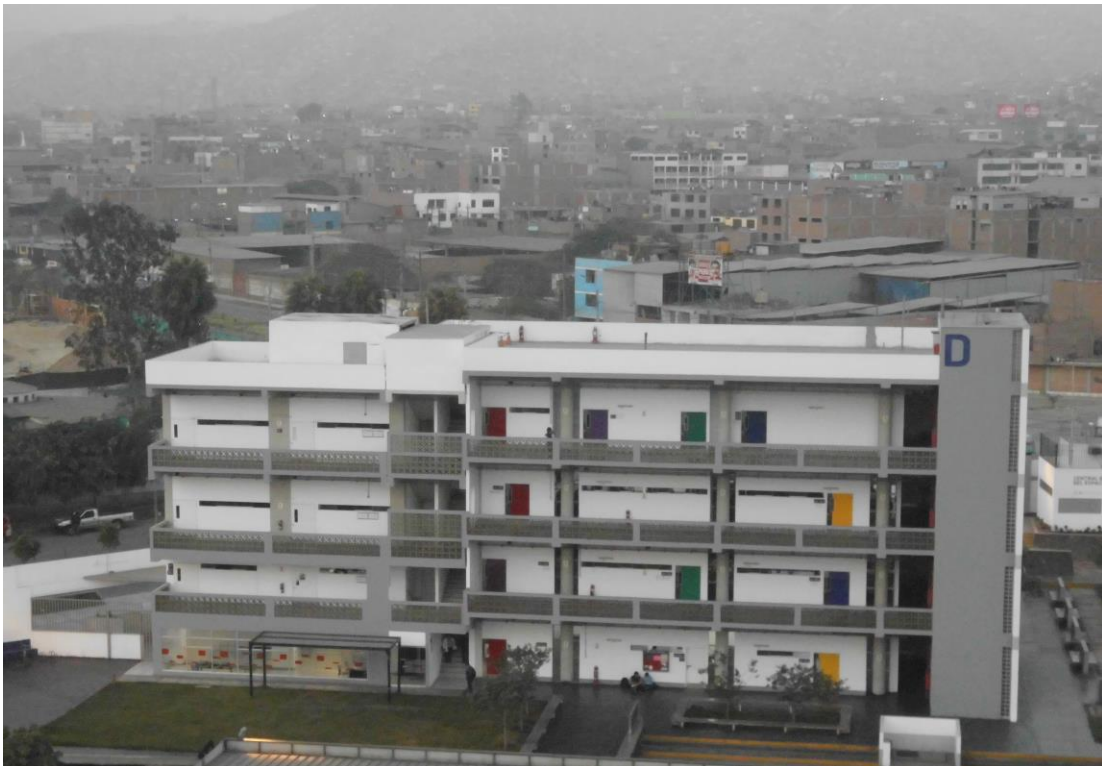
Anexo 21: Fotografía del edificio del Pabellón “D” de la UCV-Sede Lima – Este. Fuente: Elaboración Propia. Fecha 02 de Julio de 2018.
