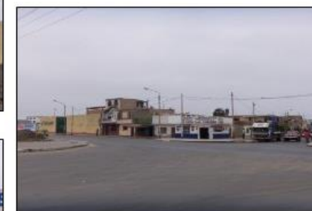
Vista perspectiva a Jr. Moquegua desde la av. Pardo
