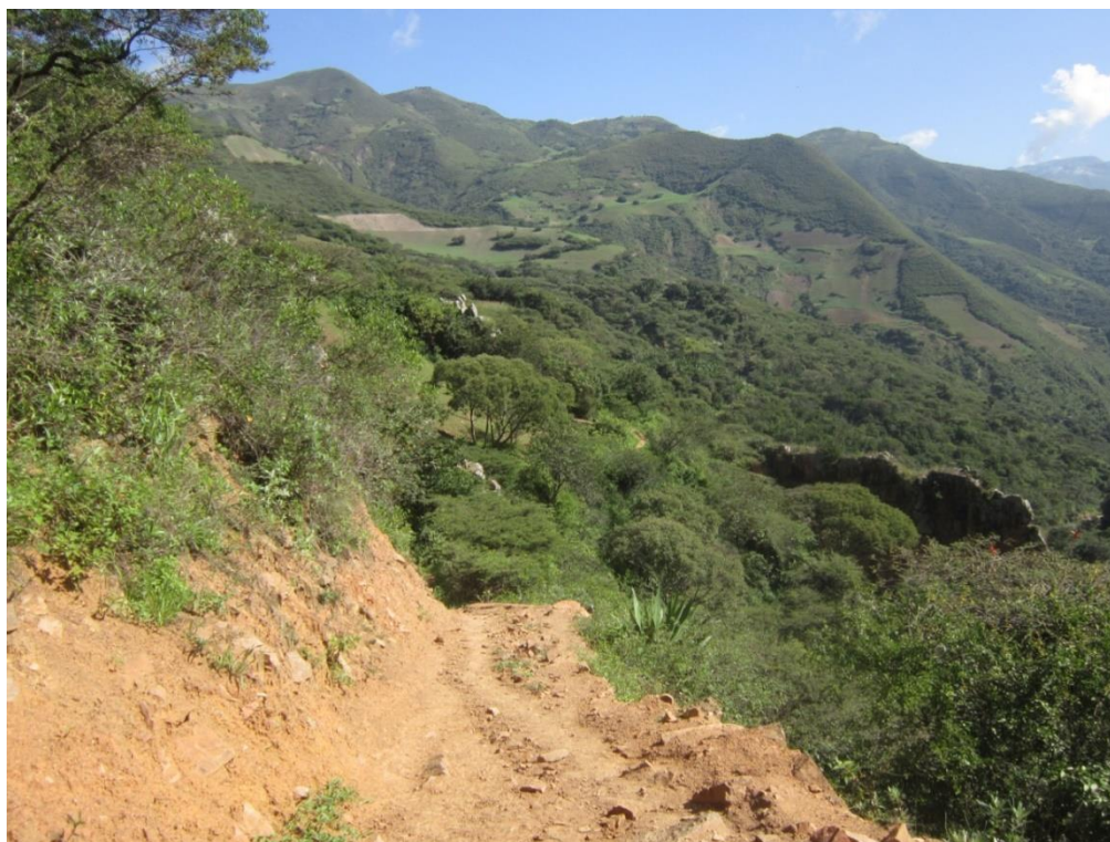
Foto 02: SE OBSERVA OTRA ZONA POR DONDE SE LLEVARA EL AGUA ATRAVES DE LA LÍNEA DE CONDUCCIÓN
