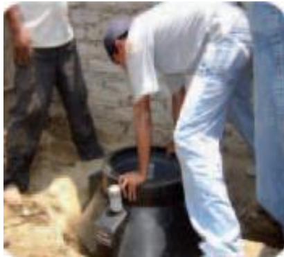
IMAGEN N° 19: Colocación de Biodigestor
