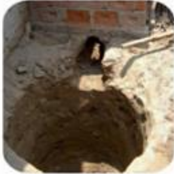
IMAGEN N° 17: Excavación para Biodigestor
