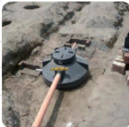
IMAGEN N° 23: Compactado para Biodigestor
