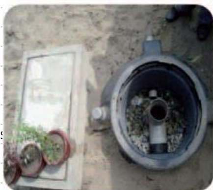
IMAGEN N° 26: Caja de Registro de Lodos
