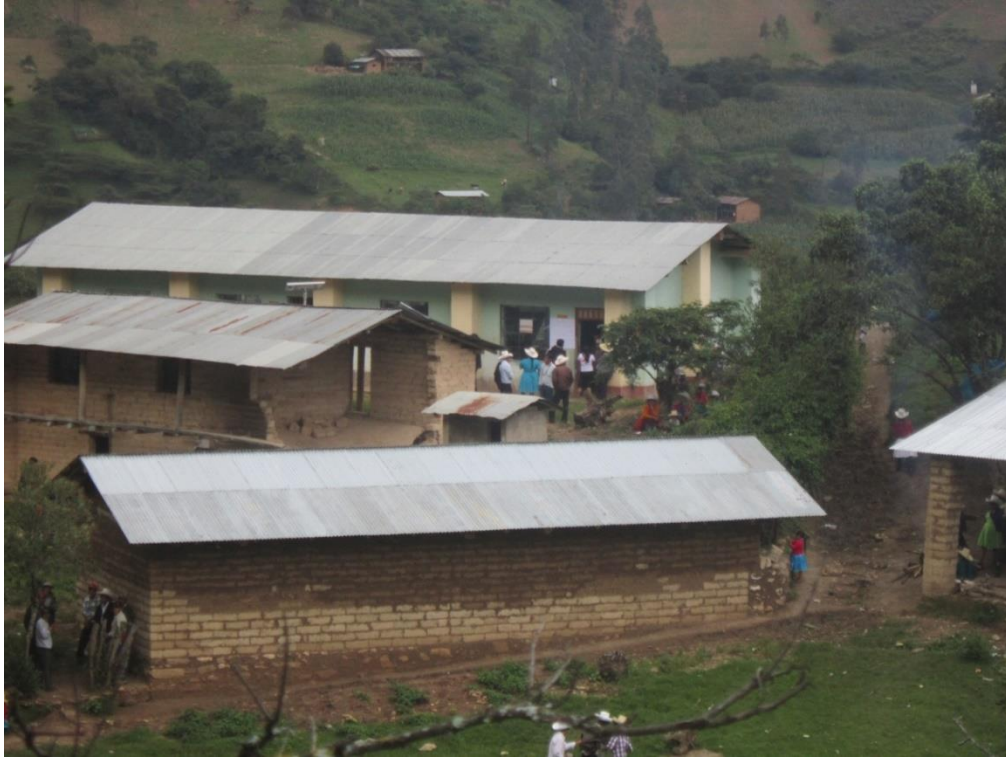
FOTO 09: SE OBSERVA ALGUNAS VIVIENDAS DEL CENTRO POBLADO EL MOTE DONDE SE INSTALACION SU CONEXIÓN DOMICILIARIA.
