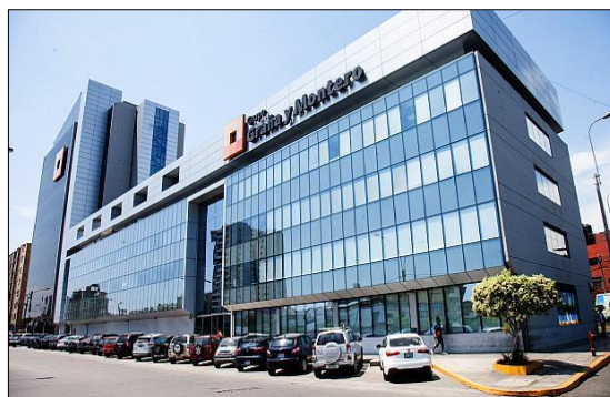
Figura 20. Vista panorámica de la edificación GRAÑA Y MONTERO.
