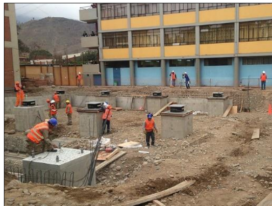
Figura 23. Vista panorámica de la cimentación del centro de informática de la UNI.
