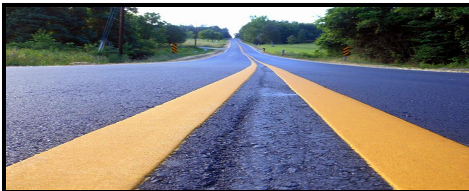
Figura 11. Termoplásticos colocados en el pavimento presentando más durabilidad.
