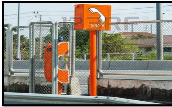
Figura 6. Casetas para brindar servicios de emergencia a los conductores.
