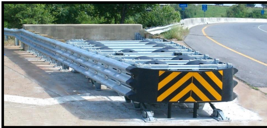
Figura 12. Amortiguador de impacto para soportar choques de los vehículos y salvar vidas de sus ocupantes.
