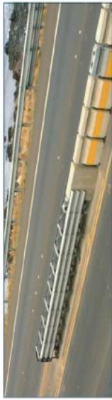
Protección de la barricada en barreras móviles
