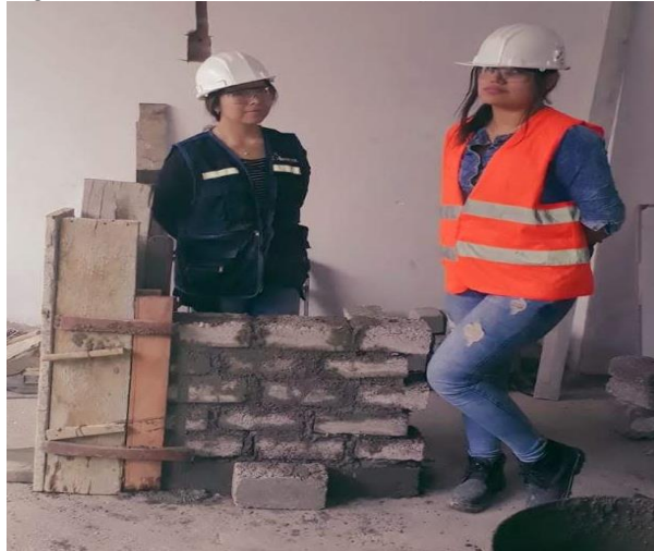
Figura 25. Encofrado de columna del muro.
