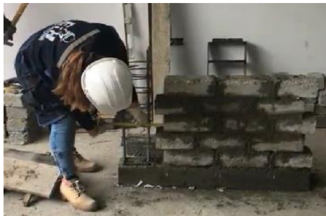
Figura 27. Medición del dentado del muro.
