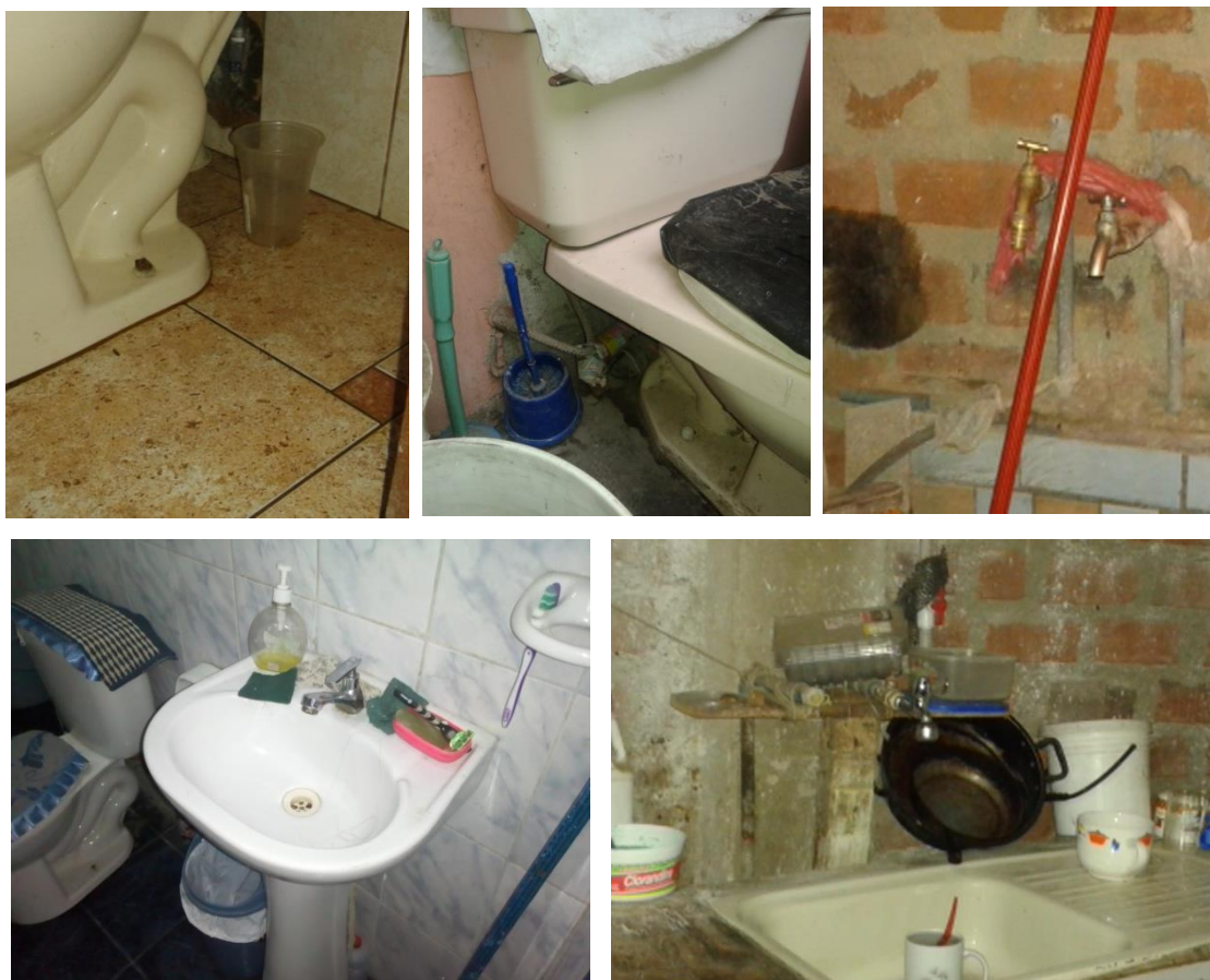
Imagen N° 3. Inventario de puntos de agua y detección de fugas
