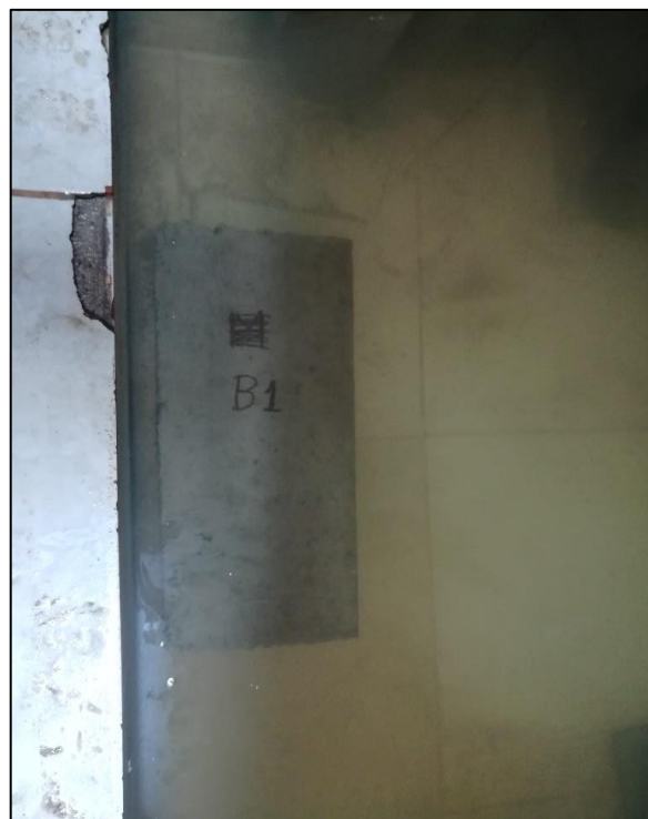
Foto N 31. Curado de los bloques de prefabricados
