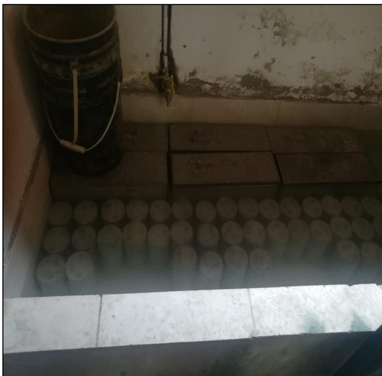
Foto N 30. Curado de los bloques prefabricados
