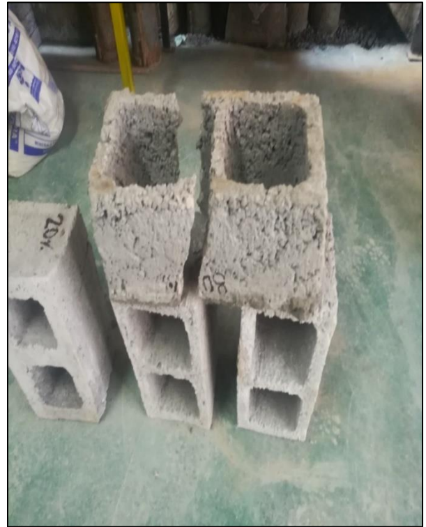
Foto N 42. Roturas del bloque de concreto al 80% de agregado reciclado
