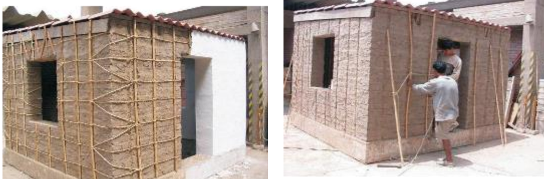
Figura 6. Reforzamiento en adobe malla natural (PNUD, 2008)2.
