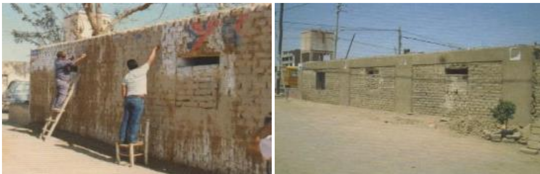
(a) Trazado de una franja horizontal (b) reforzamiento con malla electrosoldada
