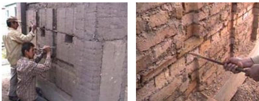
Figura 1-7: Reforzamiento con elementos de madera confinantes (AIS, 2010)
