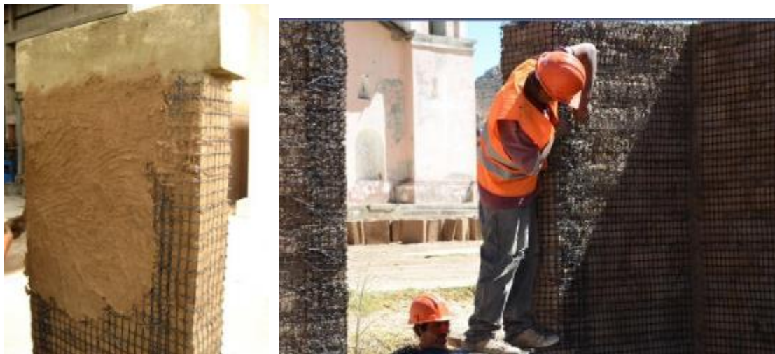
Figura 15. Colocación de la geomalla en muros de adobe.
