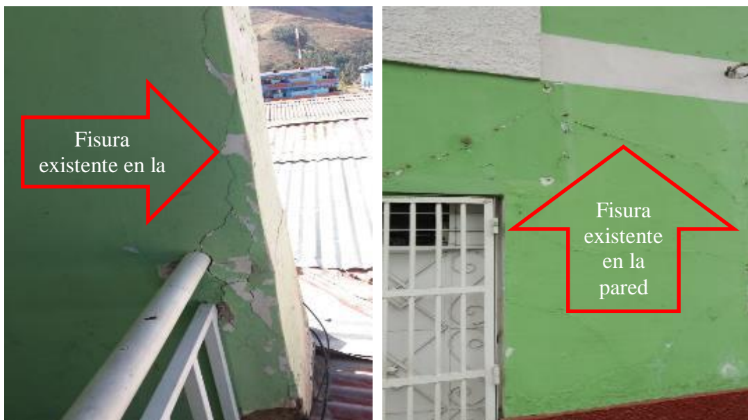
Figura 1-2: Rajaduras existentes en los muros del local municipal
