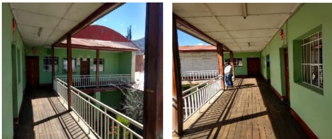
Figura 1-4: Interior del segundo piso del local municipal
