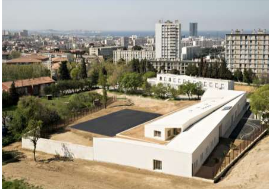
Figura 107. Centro de rehabilitación Juvenil Marsella – Francia
