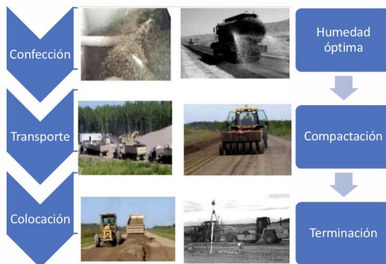
Figura 7: Etapas para la preparación de la base.
