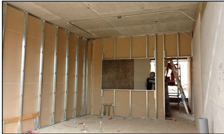
Figura 13. Construcción drywall: rieles
