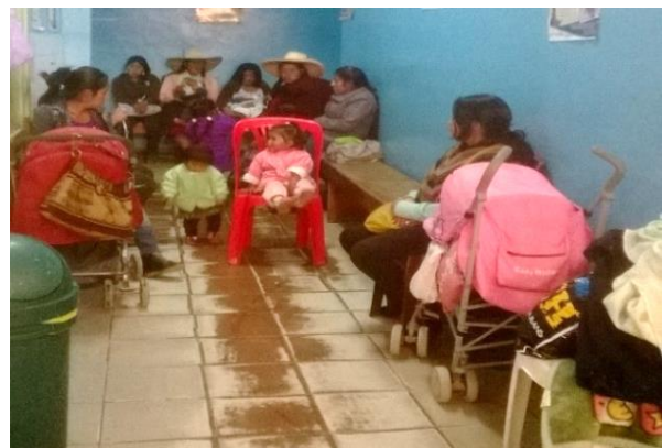
Figura 4: Pasillos de la unidad de pediatría - pisos deteriorados Fuente: Propia - 2016
