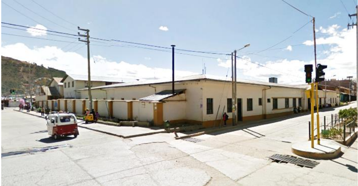
Figura 127: Volumetría del hospital no ilustrativa para la visibilidad de los usuarios Fuente: Propia - 2016
