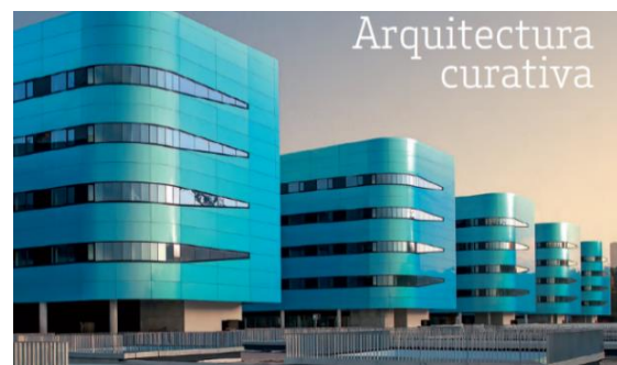
Figura 15: Bloques de hospitalización con amplia iluminación y ventilación
