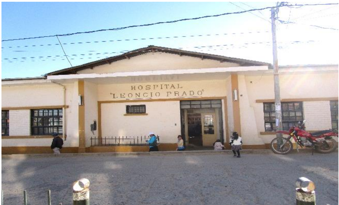
Figura 128: Fachada principal del hospital Leoncio Prado no atractiva para la visibilidad de los usuarios Fuente: Propia - 2016
