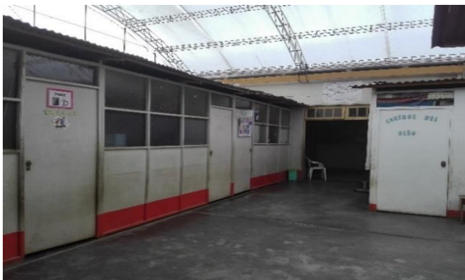
Figura 6: Consultorios Externos prefabricados
