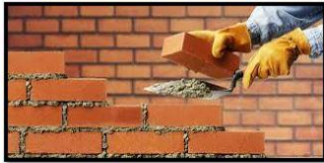
Figura 14. Muros de Albañilería.
