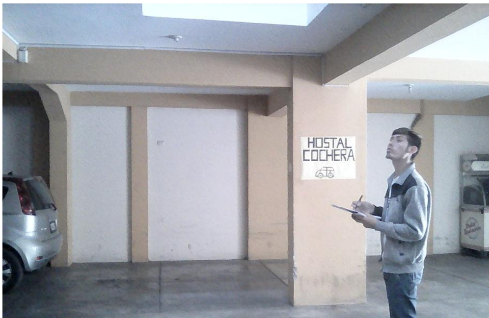
Figura 39. Corroboración de planos en el 1° nivel (Fuente: Elaboración propia)
