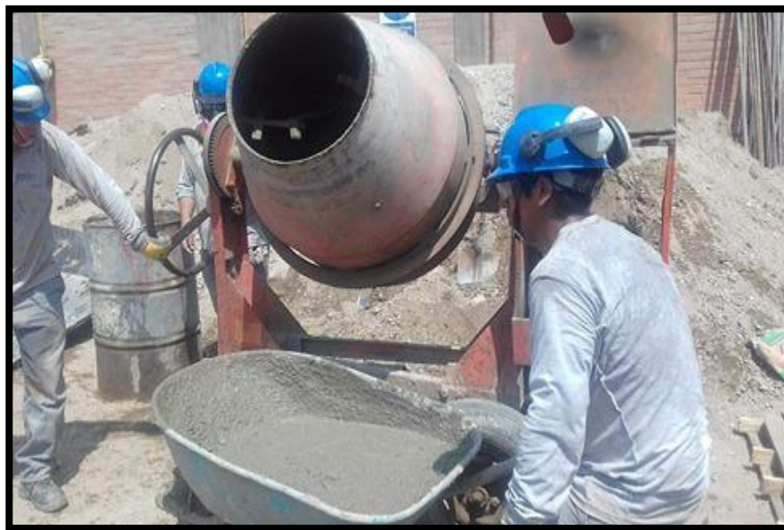
Figura 70. Vaciado de concreto con trompo.
