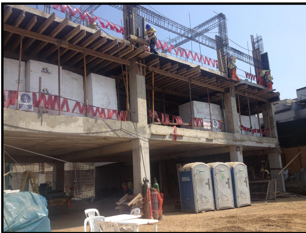
Figura 5. Proceso constructivo de proyecto local concesionario automotriz ventas y taller.
