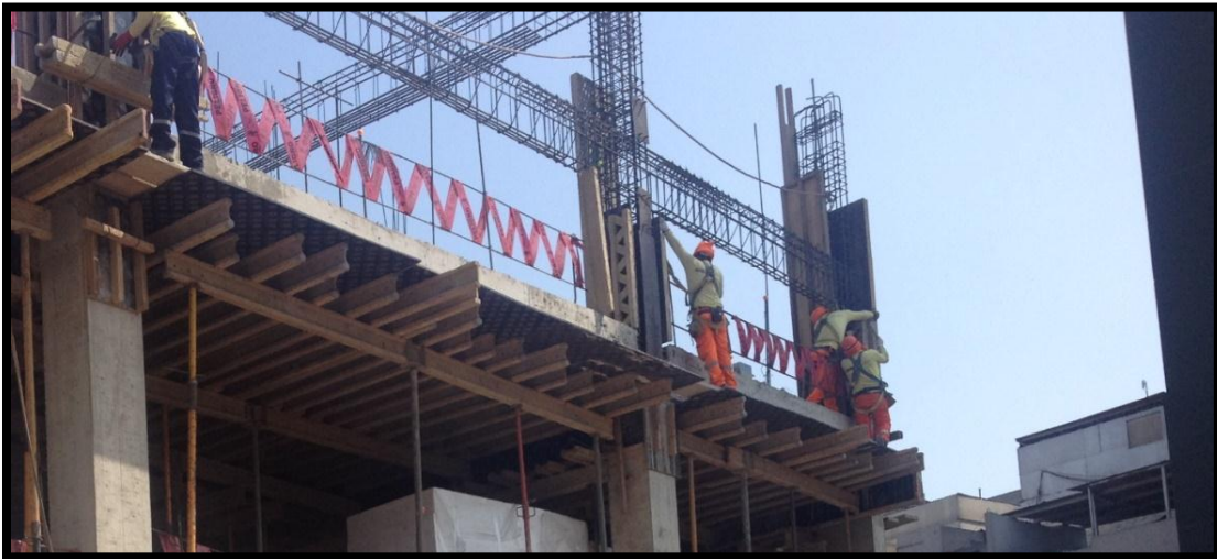
Figura 15. Con control de calidad en encofrado y desencofrado.
