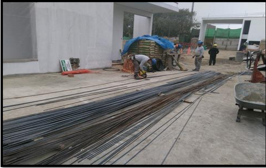
Figura 71. Habilitación de acero.
