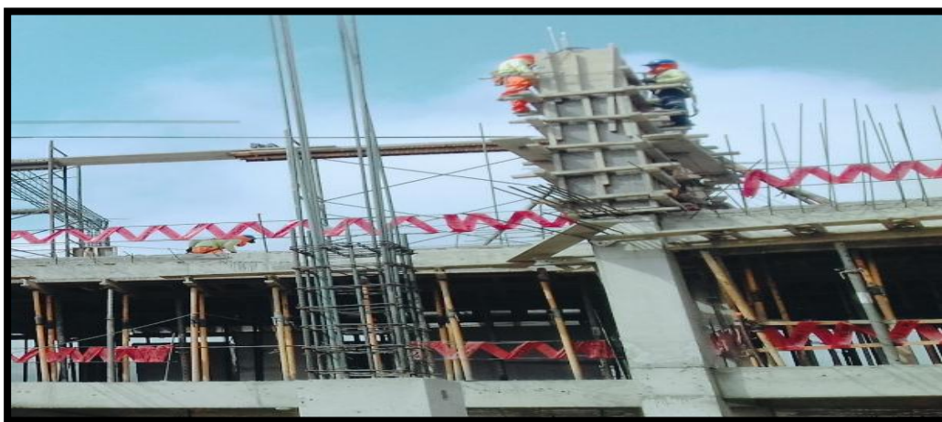
Figura 27. Encofrado de columna tercer nivel
