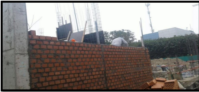
Figura 67. Pérdidas de materiales en unidades de albañilería
