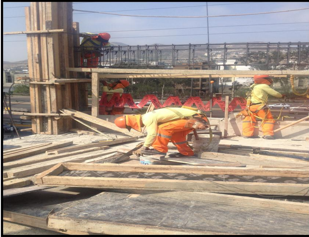
Figura 7. Encofrado y desencofrado de columnas.
