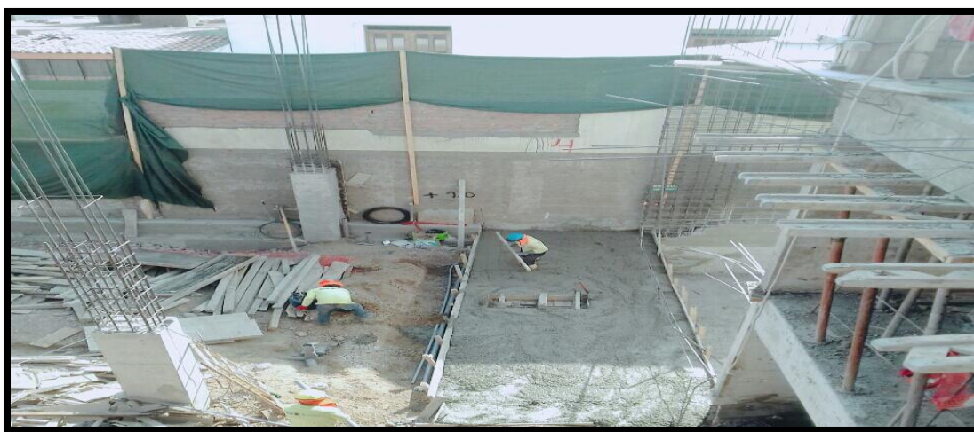
Figura 21. Vaciado de sobrecimiento armado primer nivel.
