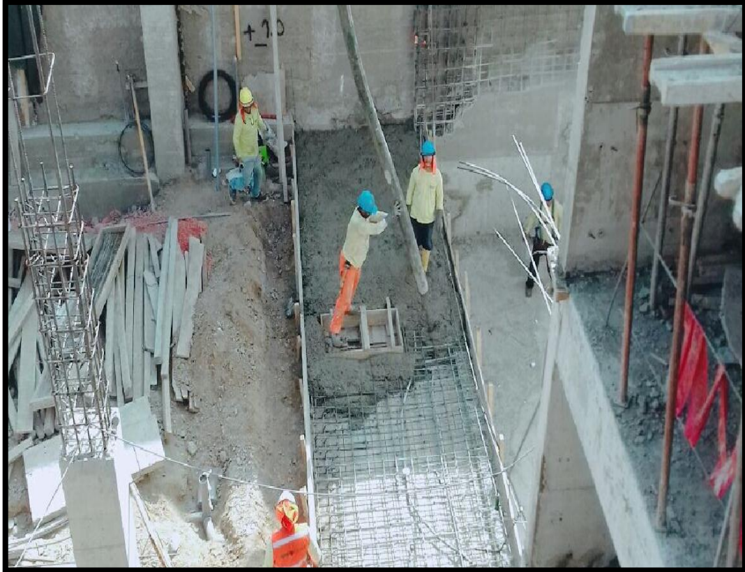
Figura 8. Vaciado de sobrecimiento armado.
