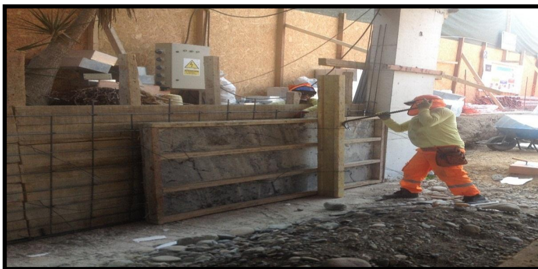
Figura 30. Encofrado de placa primer nivel.
