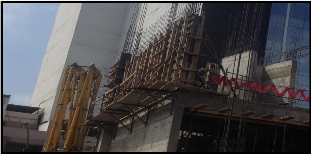
Figura 24. Vaciado de placa P-01 tercer nivel.
