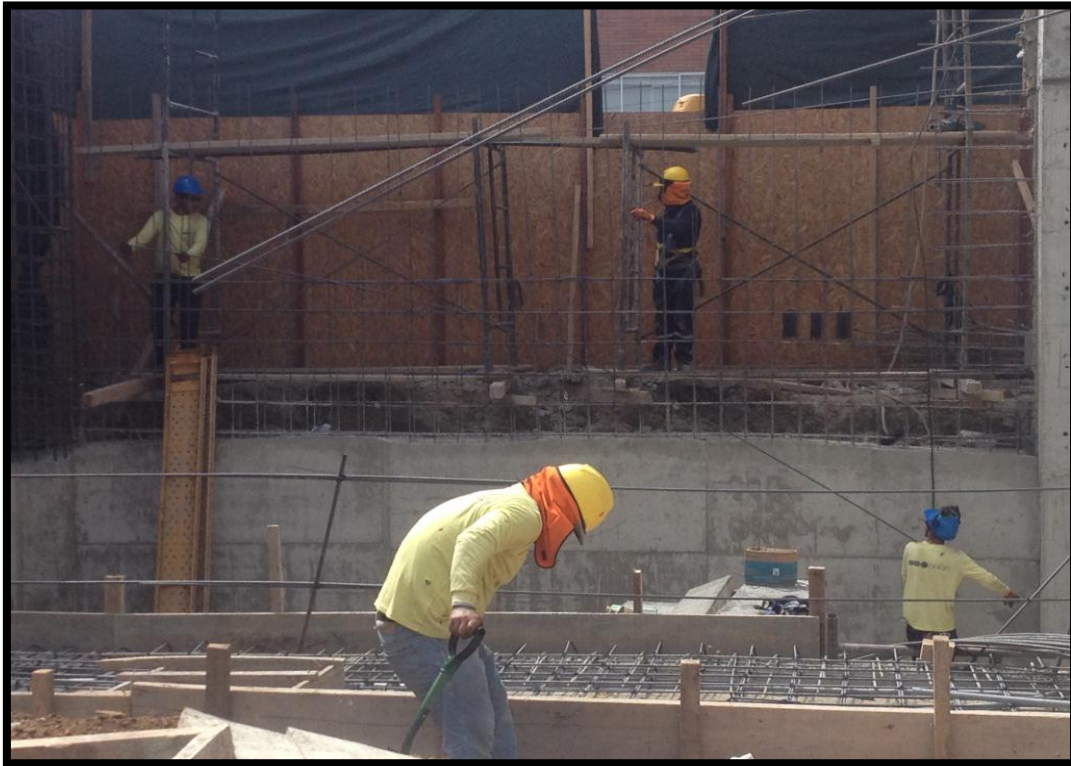
Figura 6. Armado y mediciones de acero de placa.
