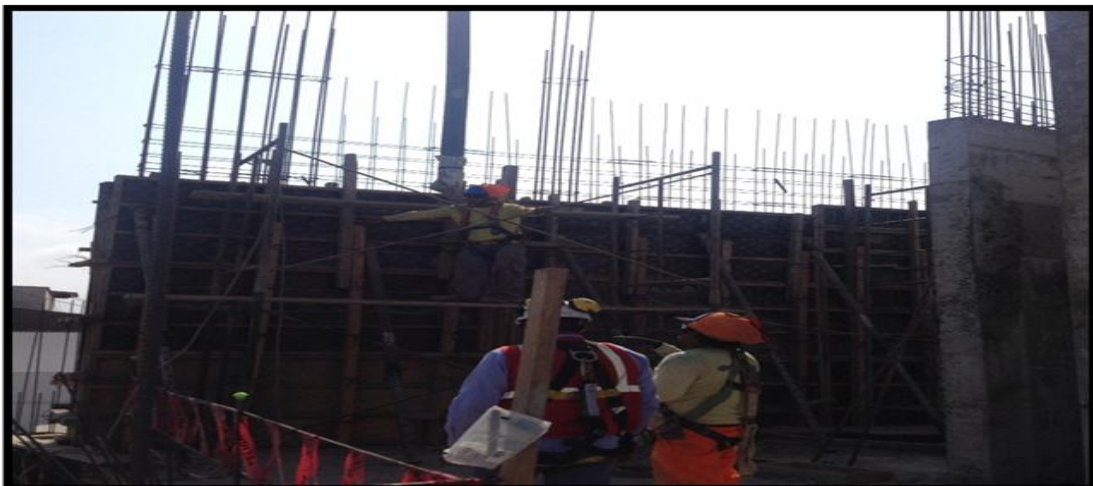
Figura 19. Con control de calidad en el vaciado de concreto.
