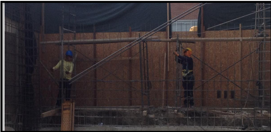
Figura 11. Con control de calidad en amarre de acero.
