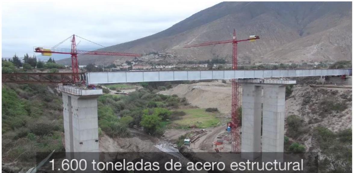
Figura 3.. Lanzamiento del puente los Pajaros en Ecuador
