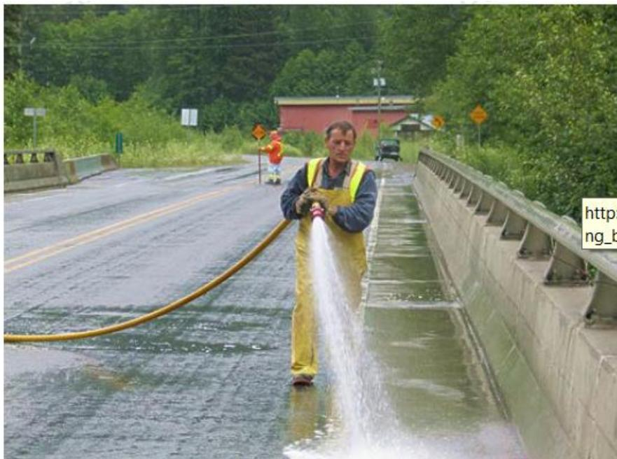
Figura 3.1. Lavar el tablero de un puente (TranBC, 2015).
