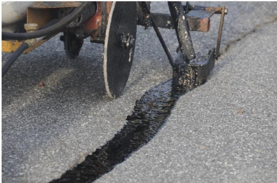
Figura 10. Sellar fisuras en el pavimento
