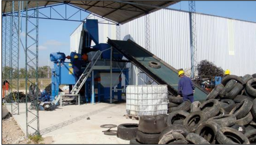
Figura N° 9 Faja transporta neumáticos al triturador primario Fuente: http://www.rubberizedasphalt.org/
