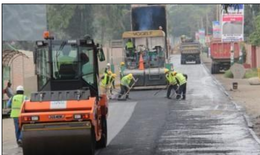
Figura N° 12 Proceso de mantenimiento de una mezcla asfáltica Fuente: Elaboración Propia
