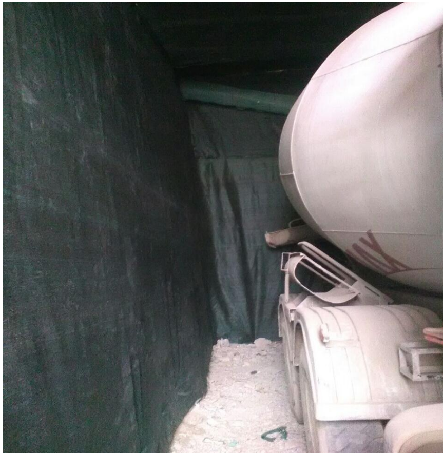
Figura N° 28: Acabado del interior del encapsulamiento acústico
