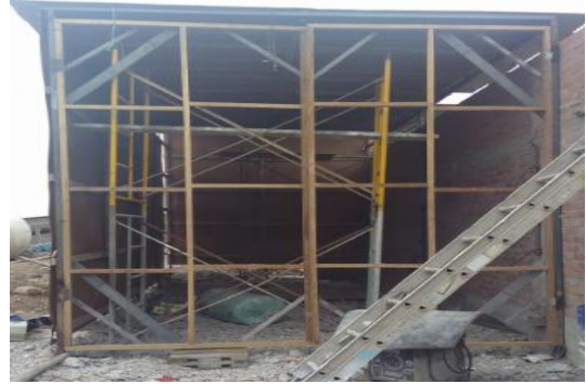
Figura N° 21: Colocar la calamina al techo e instalación la puerta
