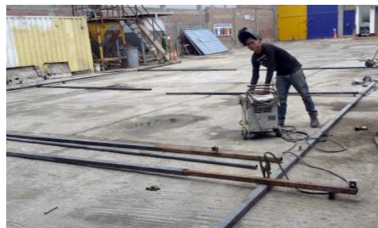
Figura N° 17: Trabajos de soldadura
