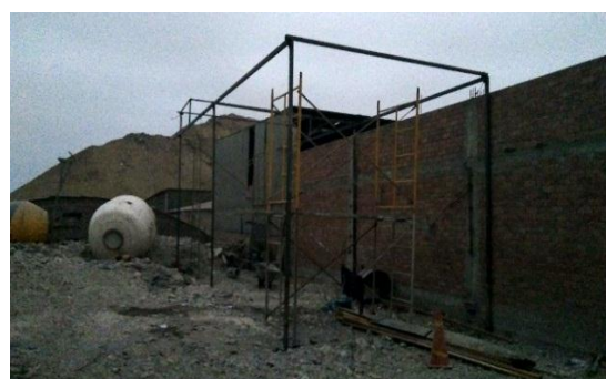
Figura N° 18: Estructura metálica principal del encapsulamiento
