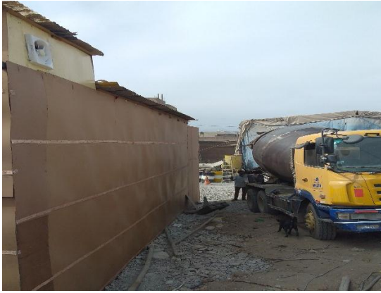
Figura N° 26: Instalación de la extractora de aire
