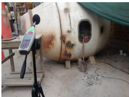
Figura N° 10: Monitoreo de ruido en el área de planchado (Rotura de concreto)
