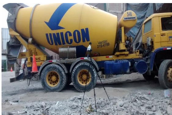
Figura N° 06: Monitoreo de ruido antes del encapsulamiento acústica final
