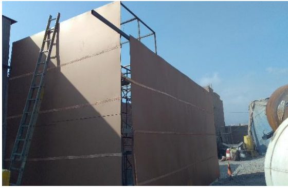
Figura N° 20: Recubrimiento de planchas de cartón compactado
