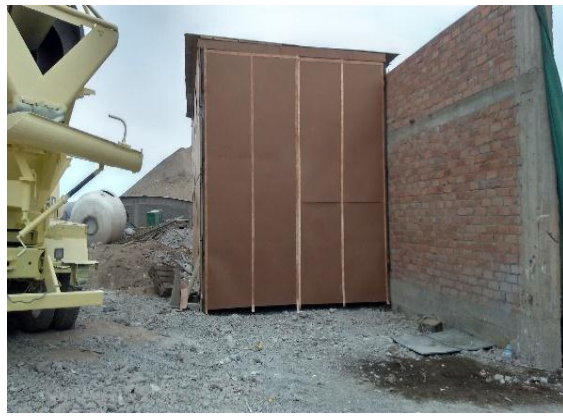
Figura N° 27: encapsulamiento acústica final
