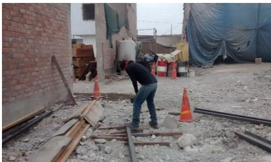
Figura N° 16: Corte de tubo cuadrado para la estructura
