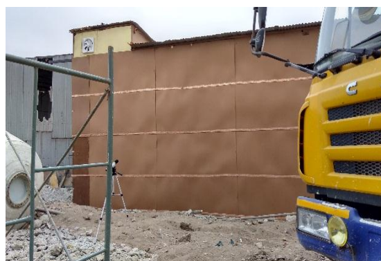
Figura N° 07: Monitoreo de ruido después del encapsulamiento acústica final
