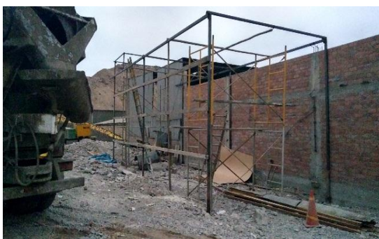
Figura N° 19: Recubrimiento de listones de madera en el contorno de la estructura
