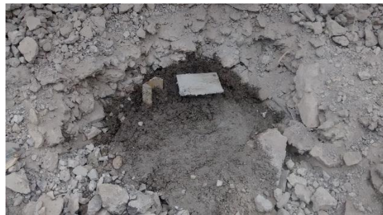
Figura N° 15: Cimentación para colocar la estructura del encapsulamiento
