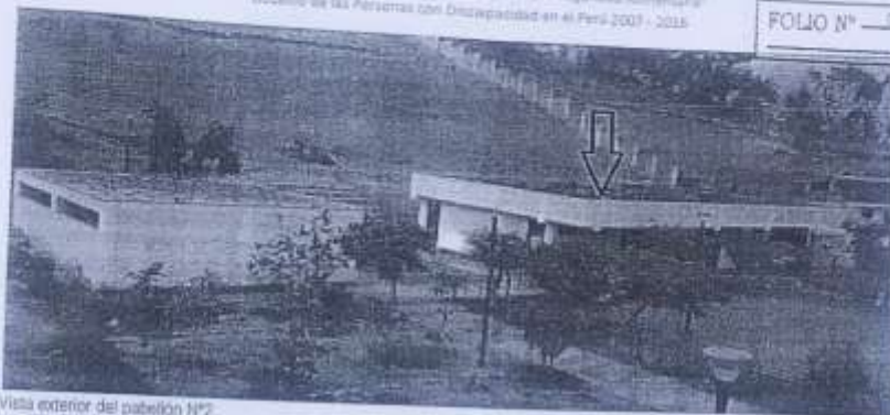
Vista exterior del pabellón N°2
