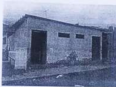
En la vista se observa el servicio higiénico del nivel primario.
