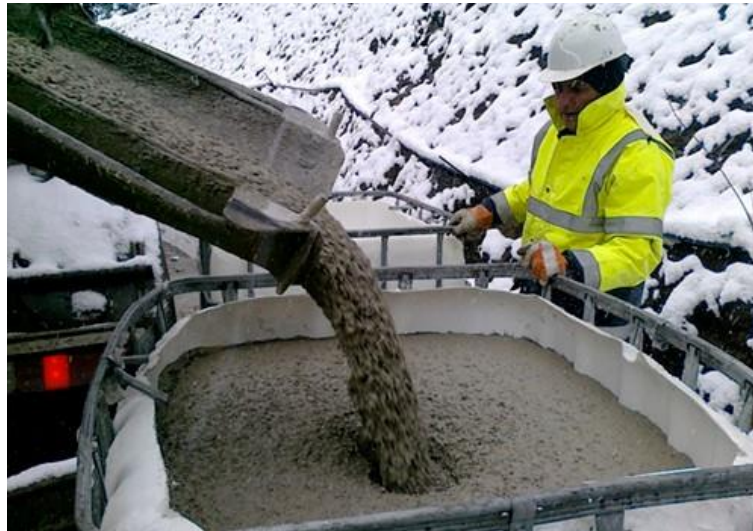
Figura N° 5: Mezcla de concreto con agregado grueso angular.
