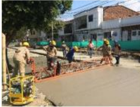
Figura 110: suministro e instalación de losa de concreto.
