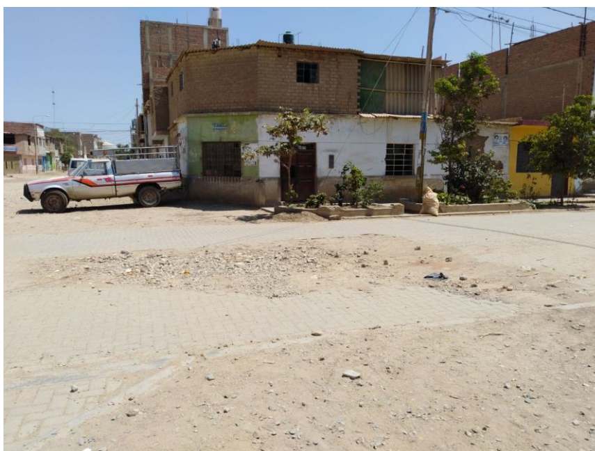
Figura 1: Vista del Estado actual de la Av. Venezuela cuadra 765
