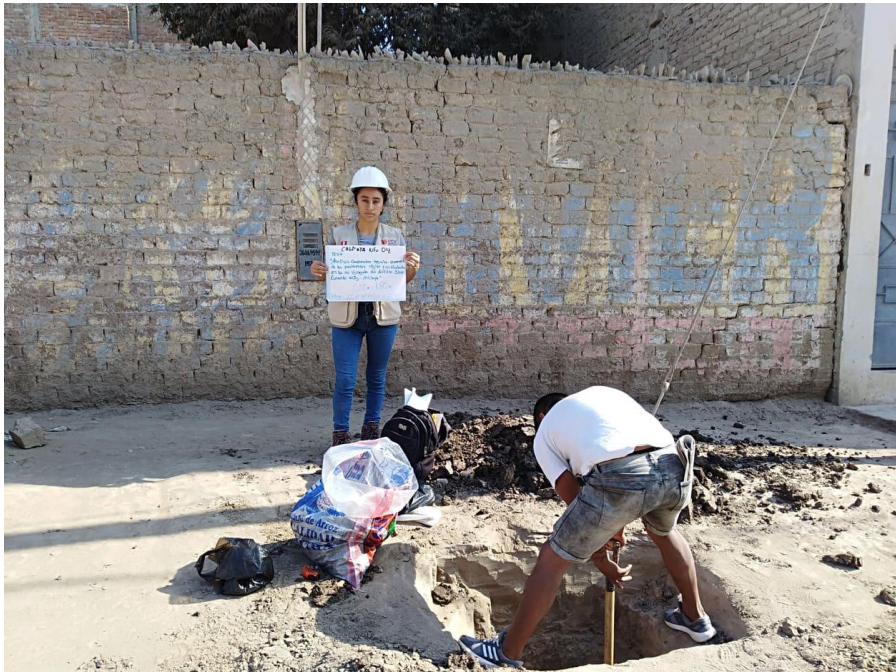
Figura 39 : excavación de calicata 04
