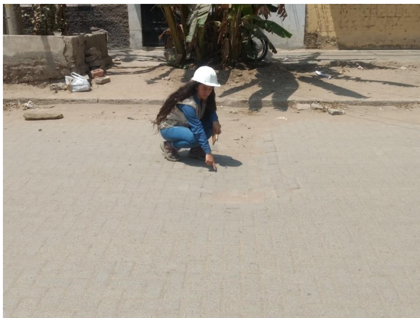
Figura 29: Tipo de falla (depresiones, Da)
