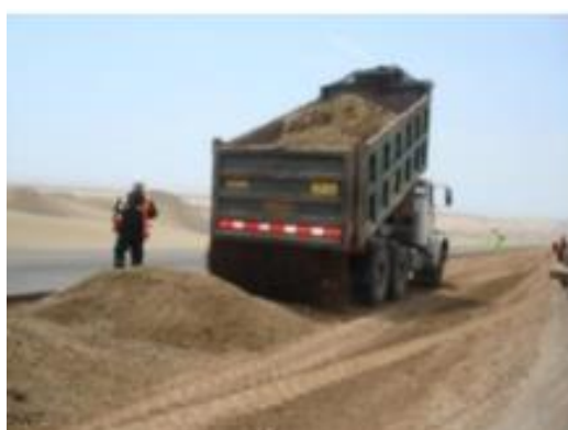
Figura 109: suministro de material para base granular.
