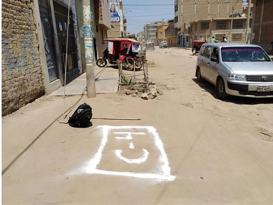
Figura 38: punto de excavación de calicata 04
