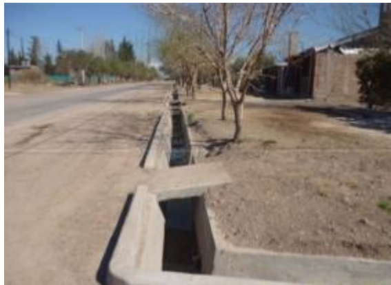
Figura 111: cuneta en el diseño de pavimento.
