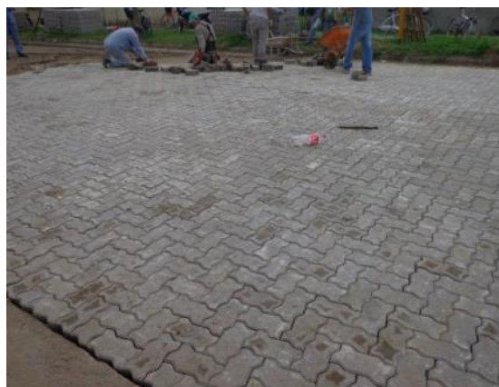
Figura 123: instalación de Adoquin
