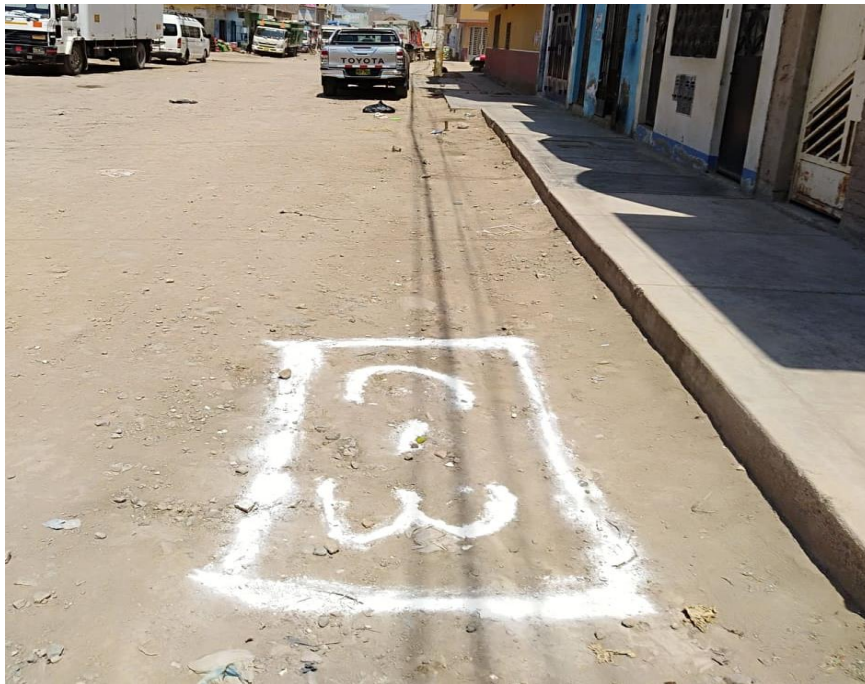
Figura 36: Punto de excavación de calicata 03
