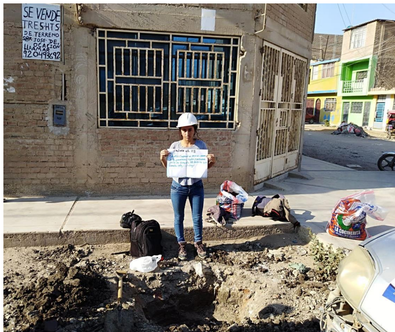
Figura 37: excavación de calicata 03
