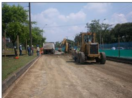
Figura 106: compactación de subrasante
