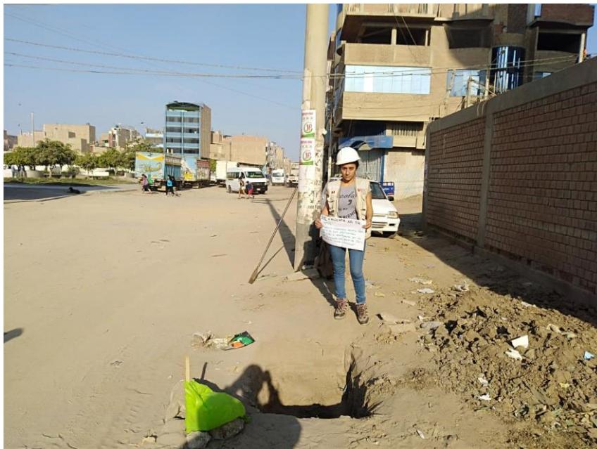
Figura 33: excavación de calicata 01.
