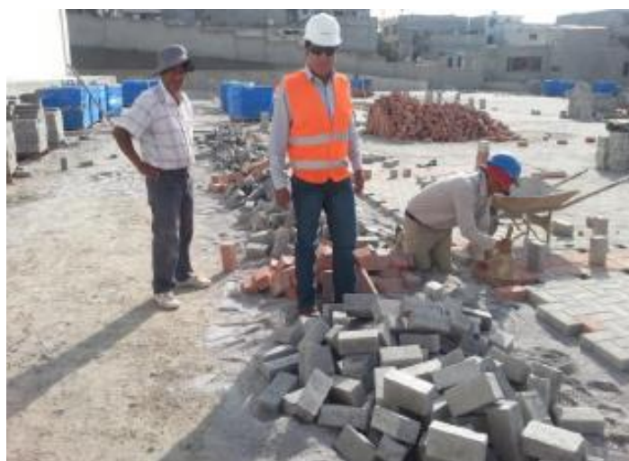
Figura 91: construcción de pavimento articulado.
