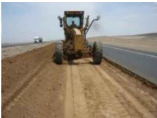
Figura 105: movimiento de tierras, proceso constructivo
