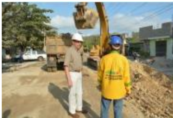
Figura 107: movimiento de tierra: eliminación de material excedente
