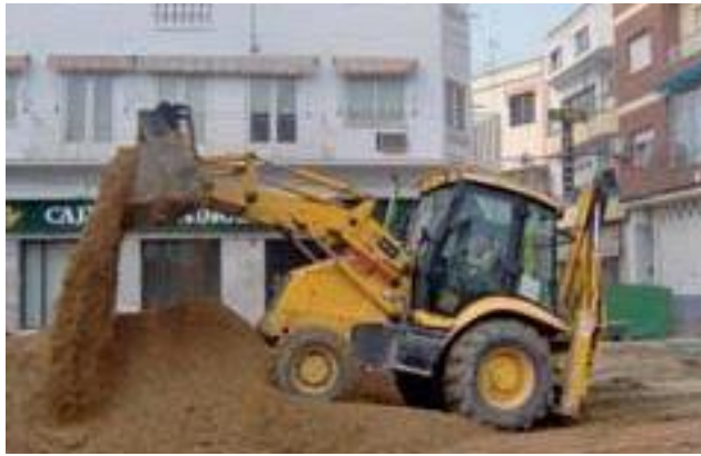
Figura 116: movimiento de tierras, pavimento articulado
