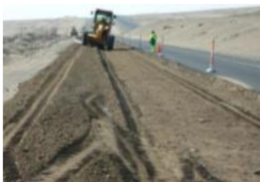
Figura 121: suministro de material base granular
