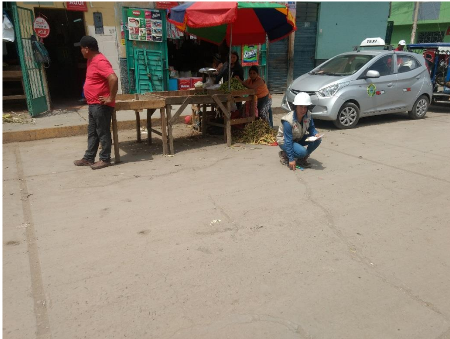
Figura 27: Tipo de Falla (grietas longitudinales)
