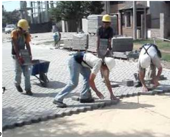
Figura 123: instalación de Adoquin
