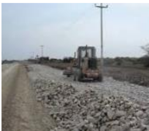
Figura 108: material over para mejoramiento
