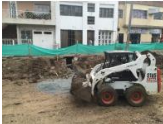
Figura 104: movilización y desmovilización de equipos
