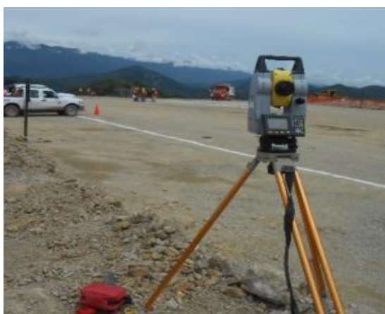
Figura 115: trazo y replanteo topográfico: pavimento articulado
