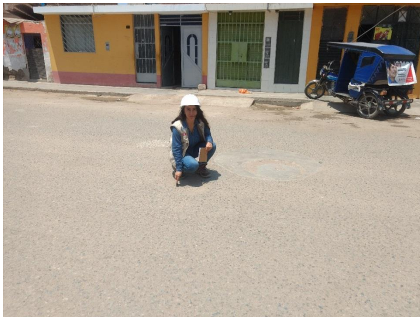
Figura 23: Tipo de falla (ahuellamiento)
