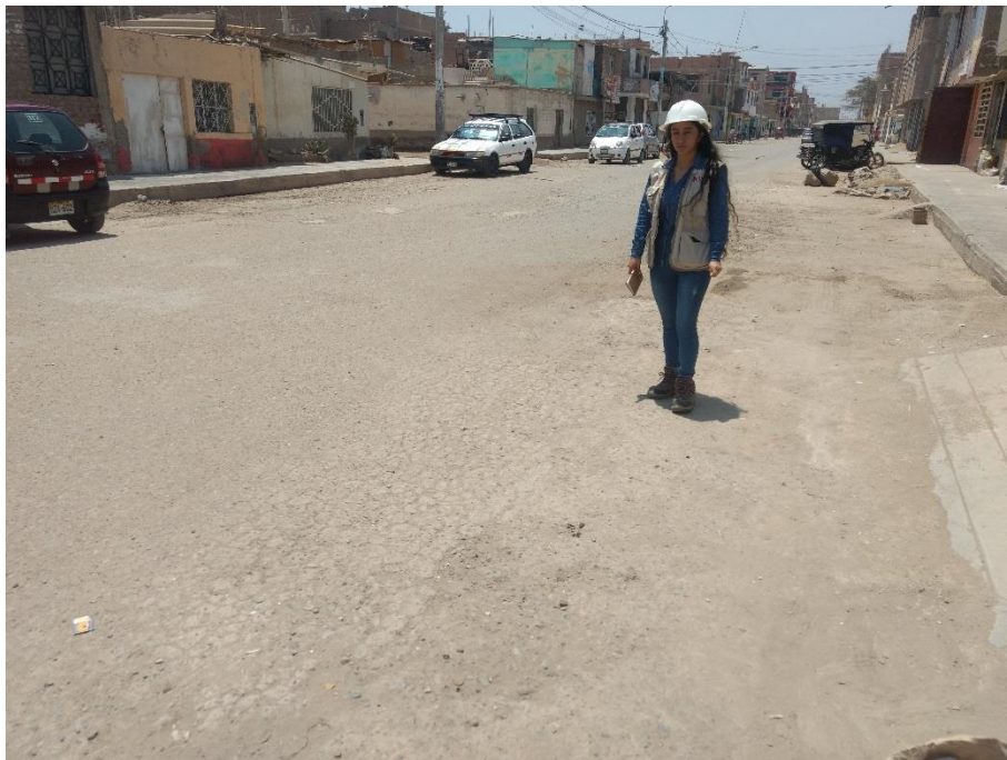
Figura 21: Tipo de falla (piel de cocodrilo)
