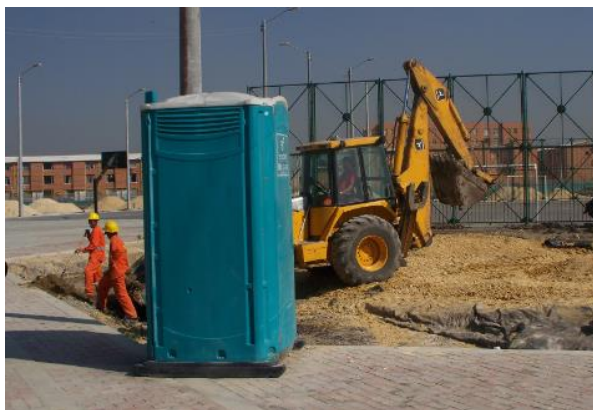
Figura 114: obras provisionales: pavimento articulado
