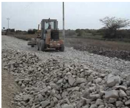
Figura 120: mejoramiento de sub-rasante con over
