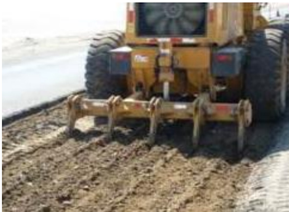
Figura 117: escarificado del suelo, pavimento articulado
