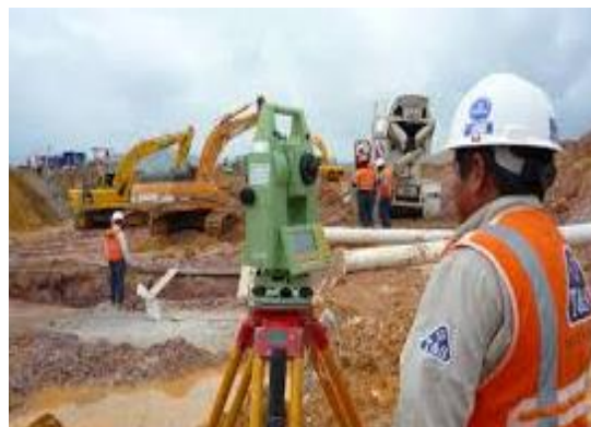
Figura 102: trazo y replanteo y control topográfico
