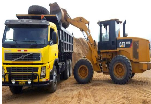
Figura 119: eliminación de material excedente
