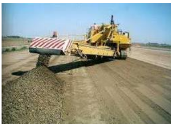
Figura 122: suministro de material sub-base granular
