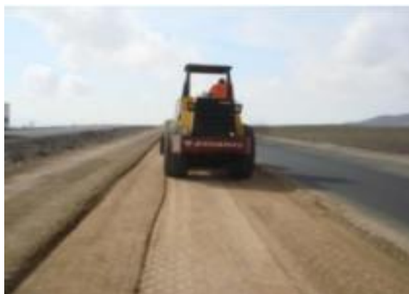
Figura 118: compactación de sub-rasante
