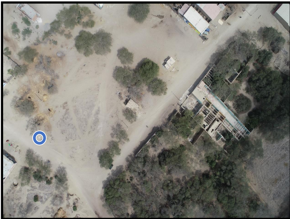
Figura 13: Vista del Drone punto de control BM-1
