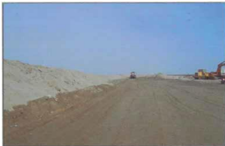
Figura 52. Proceso de compactación. (Fuente: Guerra, 2013)
