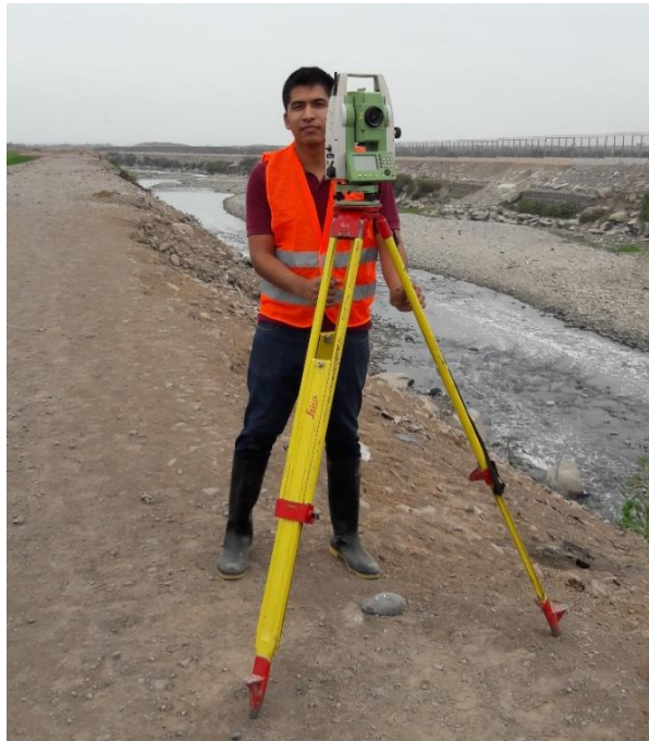
Figura 20. Levantamiento topográfico en campo. (Fuente: Propio Tesista, 2019)
