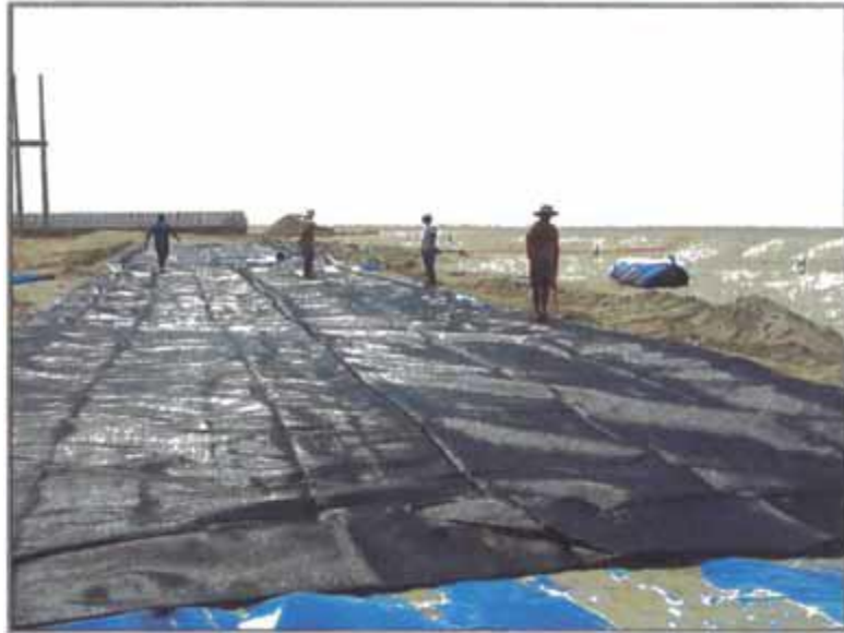
Figura 53. Colocación del manto anti socavación. (Fuente: Guerra, 2013)
