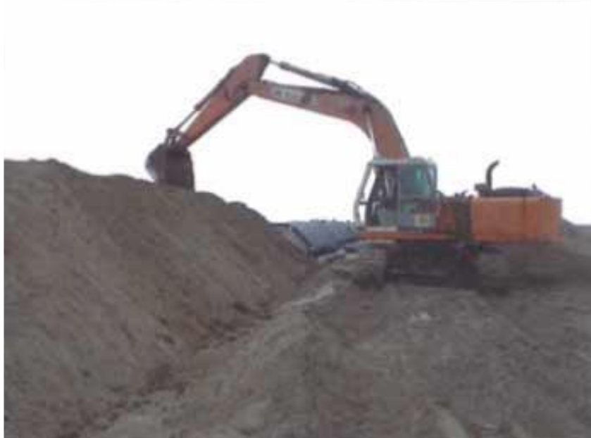
Figura 55. Fase del tapado de los geotubos. (Fuente: Guerra, 2013)
