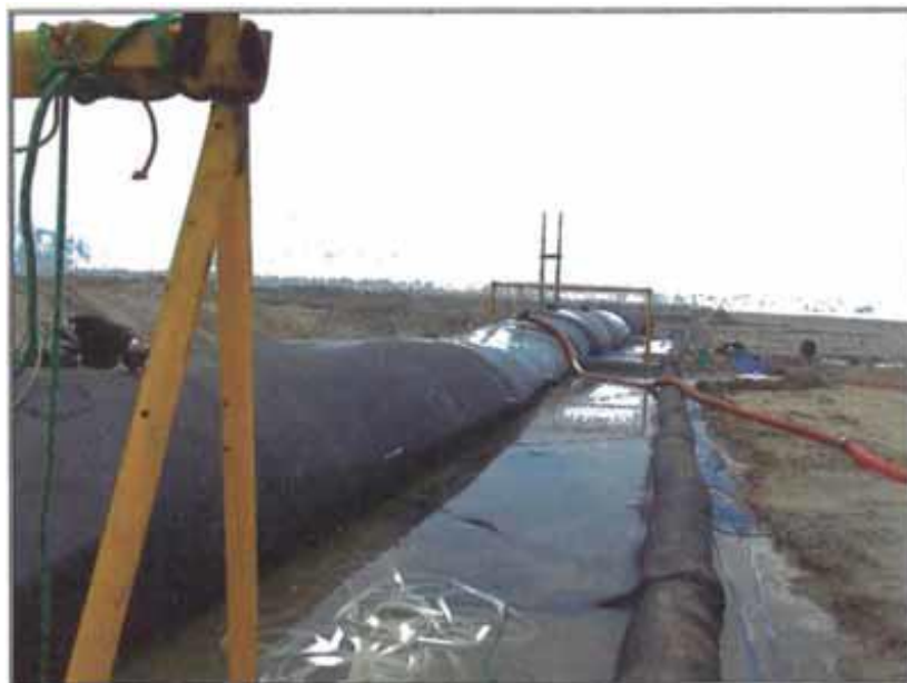
Figura 54. Proceso de llenado del geotubo. (Fuente: Guerra, 2013)
