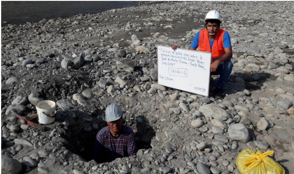
Figura 21. Excavación de la primera calicata. (Fuente: Imagen propia, 2019)
