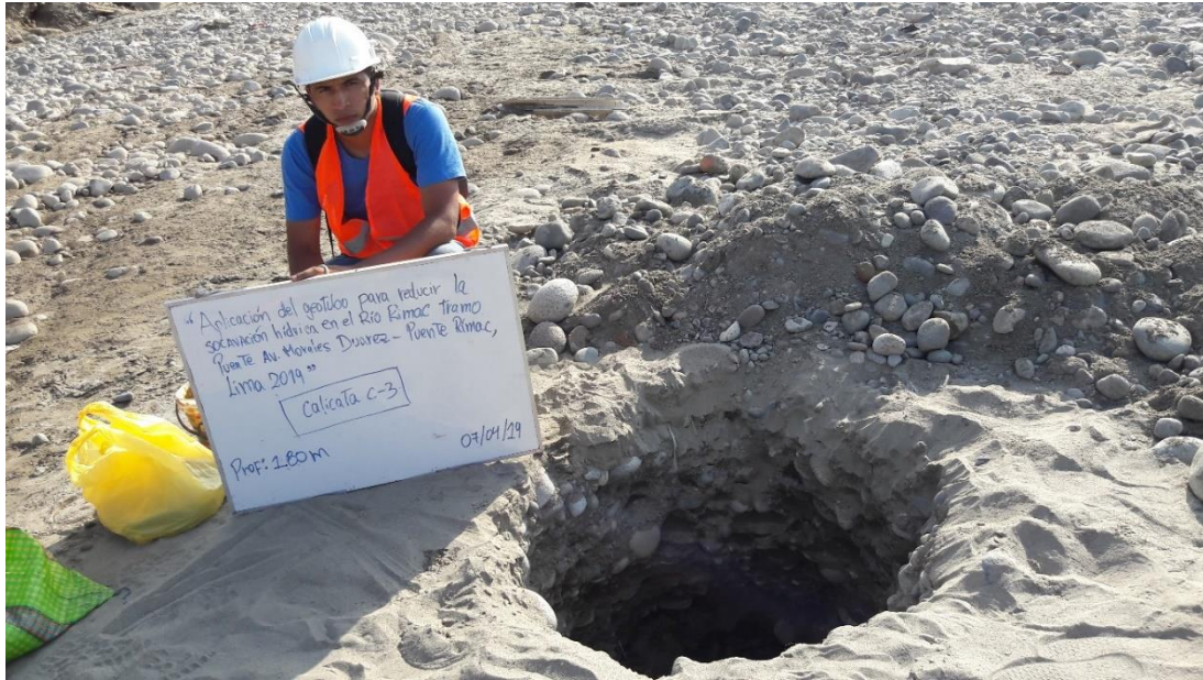
Figura 23. Excavación de la tercera calicata. (Fuente: Imagen propia, 2019)
