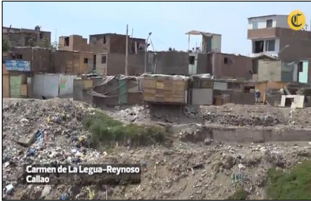
Figura 1. Proceso de socavación en la ribera del río Rímac.
