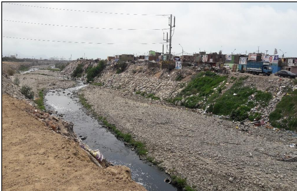
Figura 2. Estado actual del tramo de estudio.
