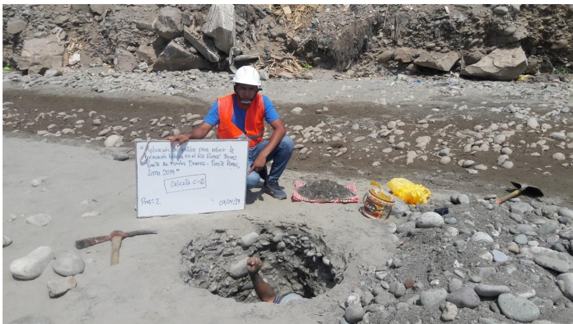
Figura 22. Excavación de la segunda calicata. (Fuente: Imagen propia, 2019)
