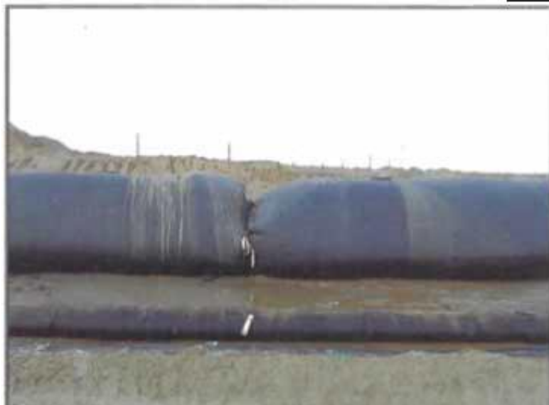
Figura 56. Colocación de geotubos. (Fuente: Guerra, 2013)
