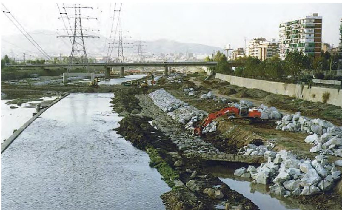
Figura 26: Inicio de obras de recuperación de la cuenca del Besós
