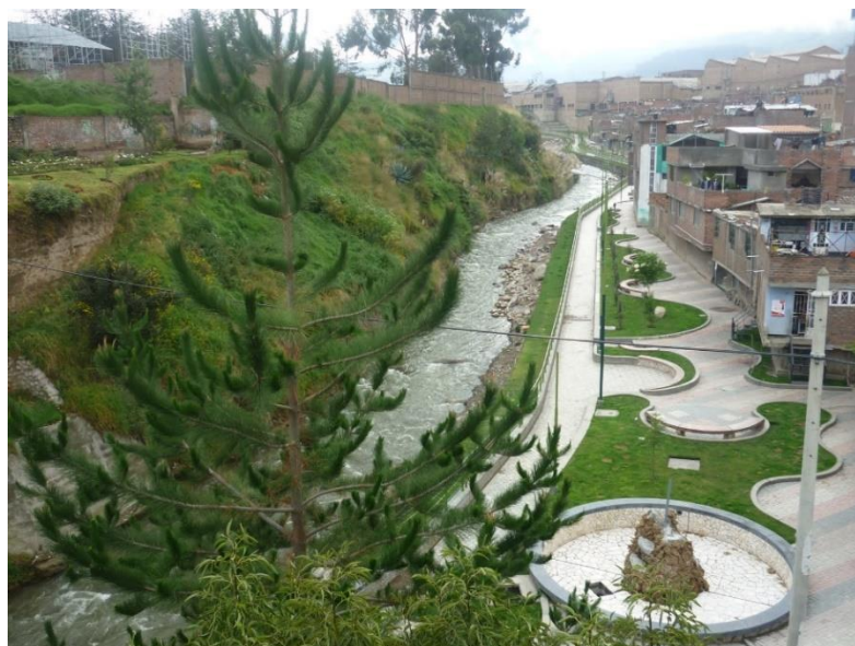
Figura 94: Rehabilitación en riberas de ríos
