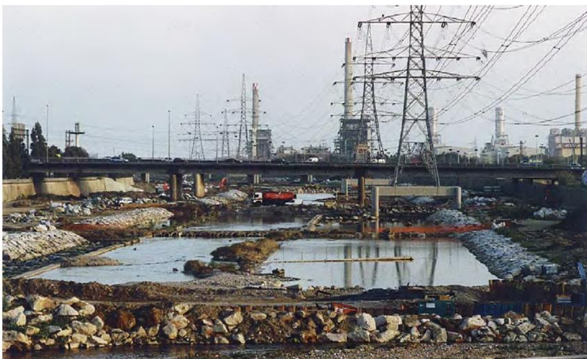
Figura 25: Río Besós en estado de deterioro
