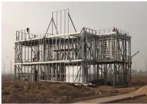
Figura N° 17. Instalación de los perfiles galvanizados Fuente: Ecohouse, 2011.
