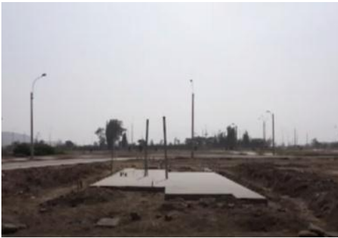
Figura N° 15. Vaciado de losa de cimentación Fuente: Ecohouse, 2011.
