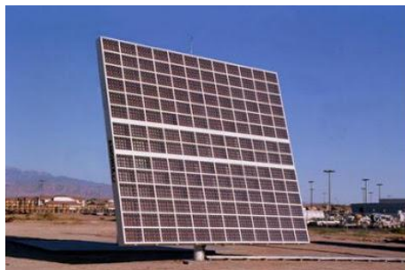
Figura N°5. Energía solar Fotovoltaica. Fuente: Casa Ecológicas, 2009.
