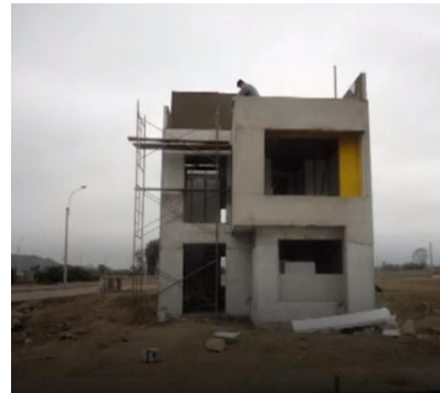
Figura N° 18. Colocación de las placas de yeso Fuente: Ecohouse, 2011.
