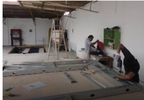
Figura N° 16. Armado de los perfiles galvanizados Fuente: Ecohouse, 2011.
