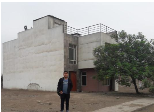
Figura N° 19. Sistema constructivo ecológico (Sistema constructivo en seco-Drywall) Fuente: elaboración propia.
