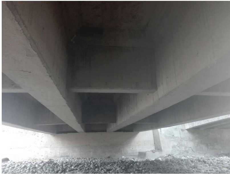
Vista de la losa de concreto armado del Puente Chancay en sentido de la vía Sur a Norte
