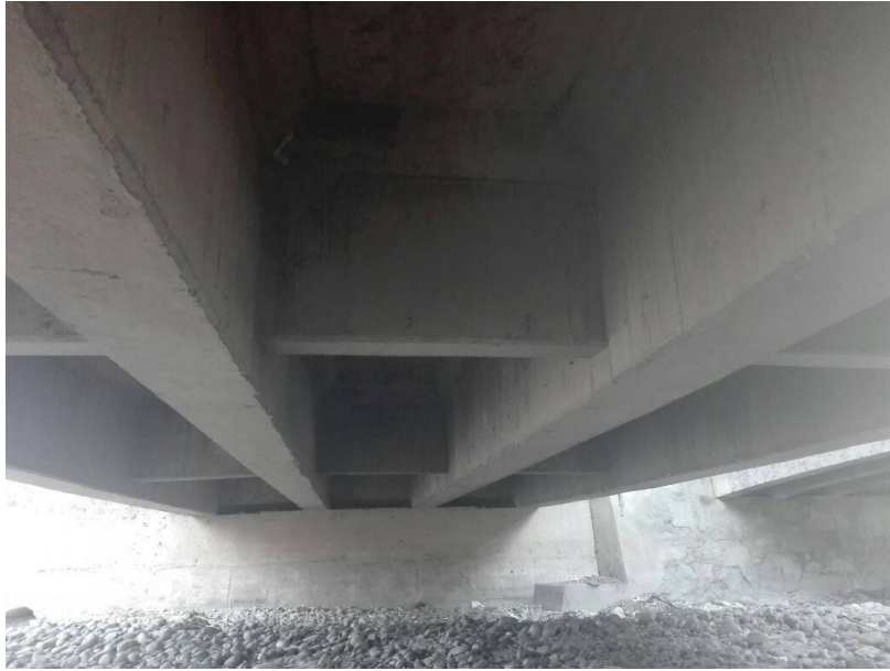
Vista del estribo con dirección al Sur del Puente Chancay en sentido de la vía Sur a Norte.
