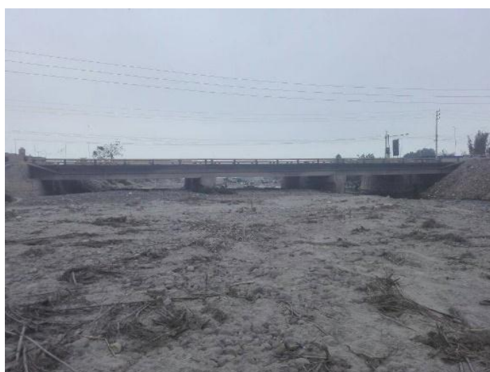
Figura 2: Vista frontal del Puente Chancay
