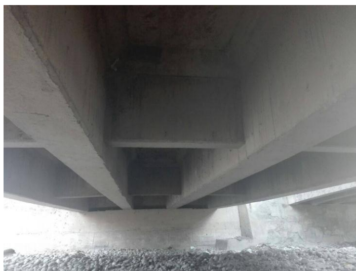
Figura 1: Vista de vigas del puente Chancay
