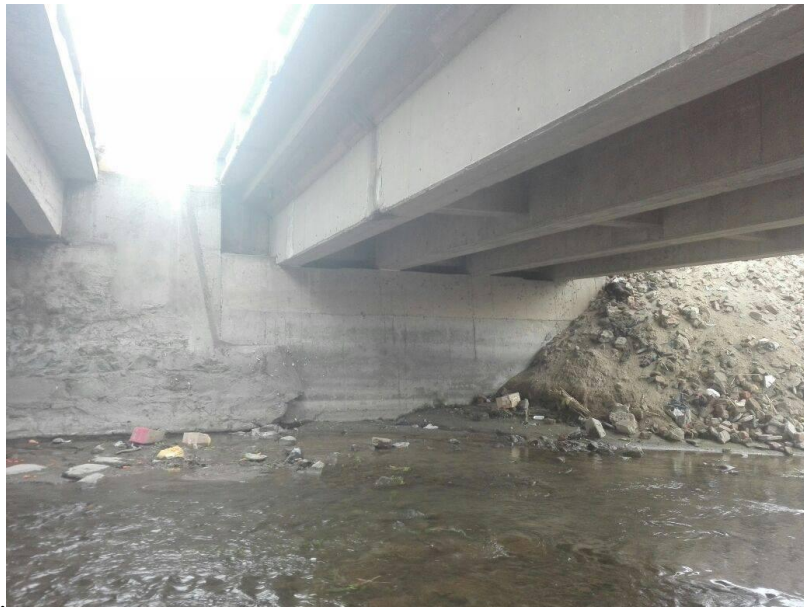
Vista del estribo con dirección al Norte del Puente Chancay en sentido de la vía Sur a Norte.
