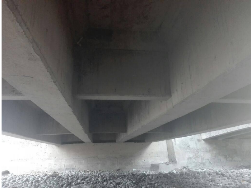
Vista de las vigas del Puente Chancay en sentido de la via Sur a Norte
