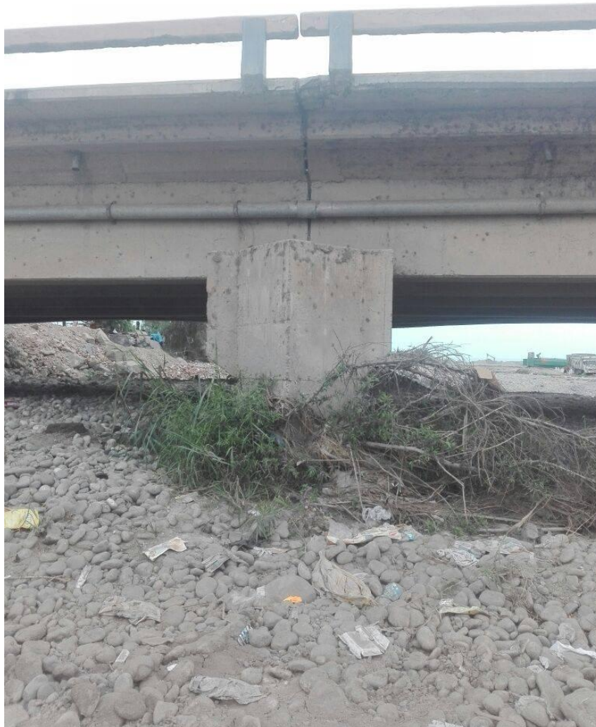
Vista de los pilares del Puente Chancay en sentido de la via Sur a Norte
