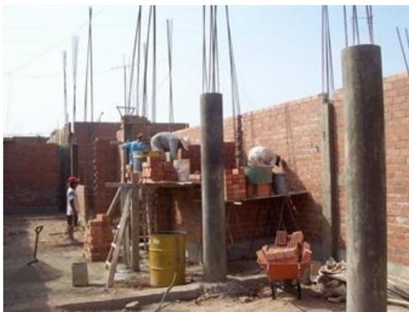
*Figura 2. proceso constructivo de viviendas de albañilería confinada en Ate*
