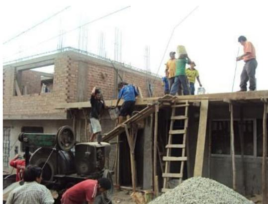
*Figura 8. preparado de concreto en obra para vaciado en losa aligerada*
