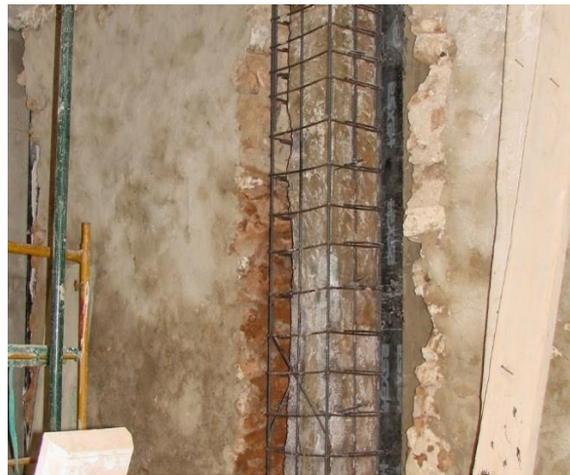
*Figura 18 aumento de sección de columna mediante encamisado de columna*
