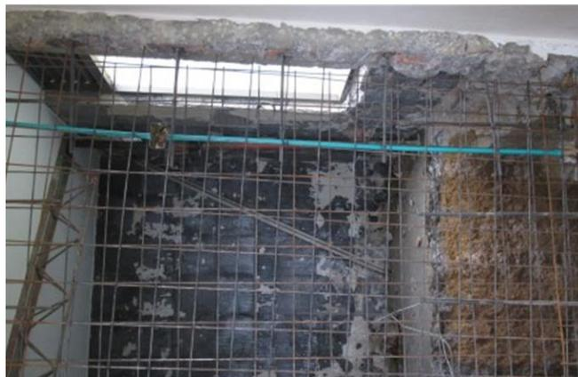
*Figura 19. sustitución de muros de albañilería en reforzamiento con muros de corte*
