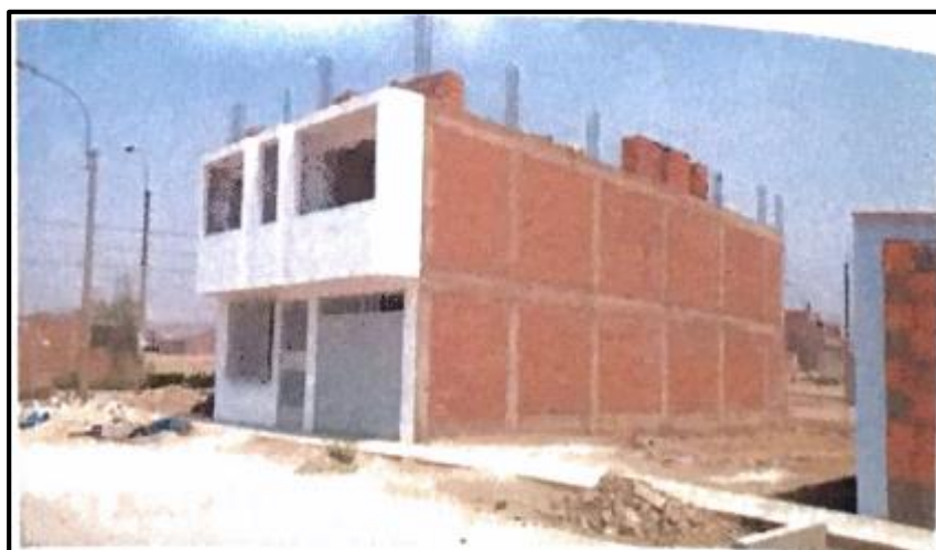
Figura 15. Edificación de albañilería confinada.
