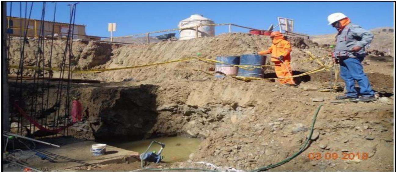
DESCRIPCION: EXTRACCIÓN DE AGUA EXISTENTE EN EL PABELLON N° 09 CON ELECTROBOMBA.
