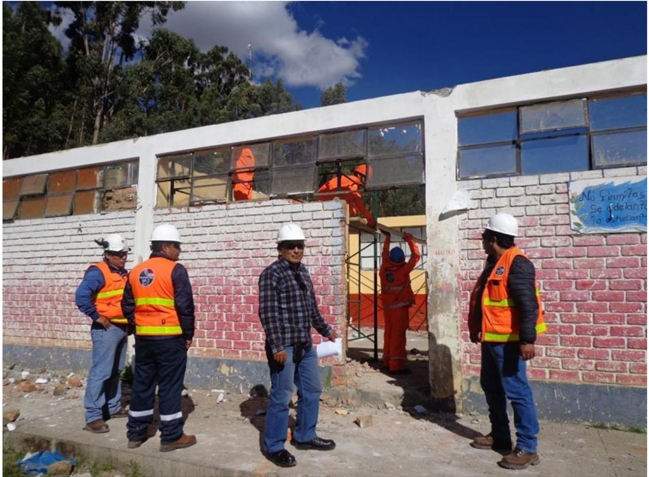
**Imagen 01:** Desmontaje de puertas y ventanas
