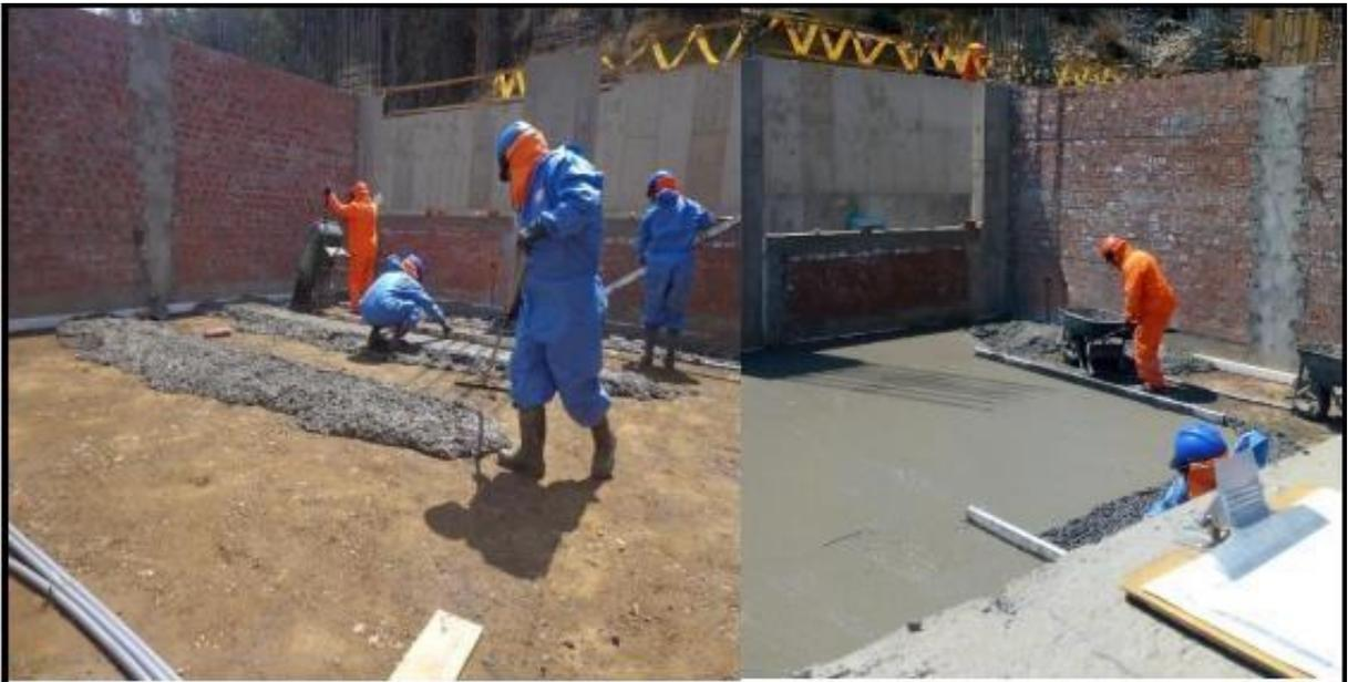
DESCRIPCIÓN: VERIFICACIÓN DEL VACIADO DE FALSO PISO EN EL PABELLON 8.
