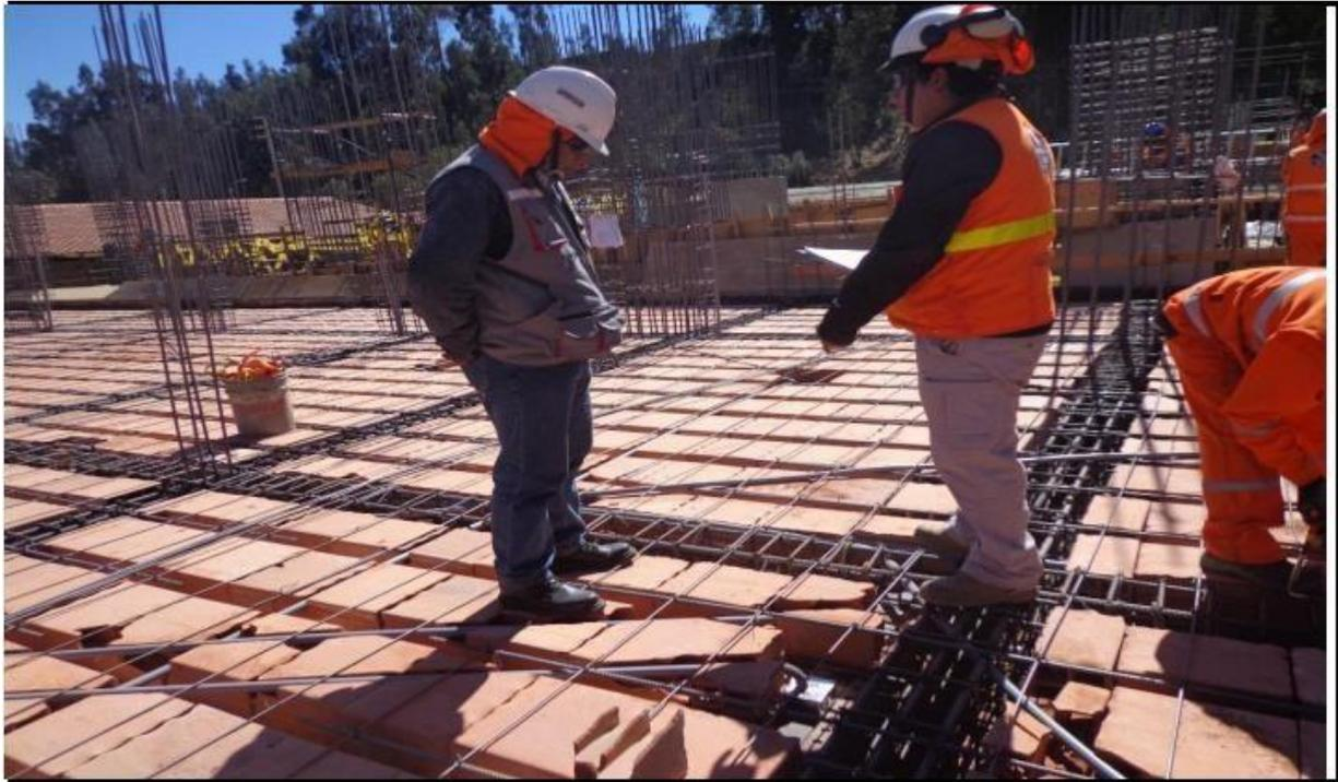
DESCRIPCIÓN: INSPECCION EN LA COLOCACION DE ACERO DE TEMPERATURA EN EL PABELLON 05.
