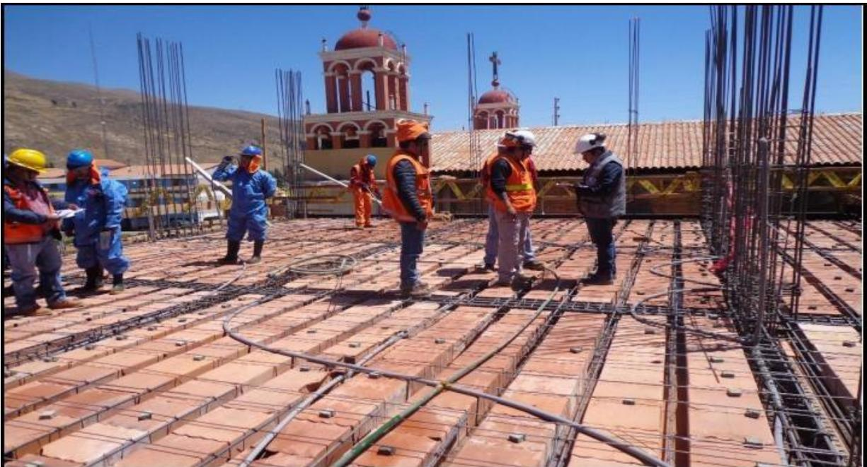
DESCRIPCIÓN: VISITA DEL ESPECIALISTA DE INSTALACIONES ELECTRICAS DE LA SUPERVISION Y EL DEL CONTRATISTA, VERIFICANDO EL TENDIDO DE TUBERÍAS EN EL TECHO DEL PABELLON 5, PREVIO AL VACIADO DE LA LOSA.
