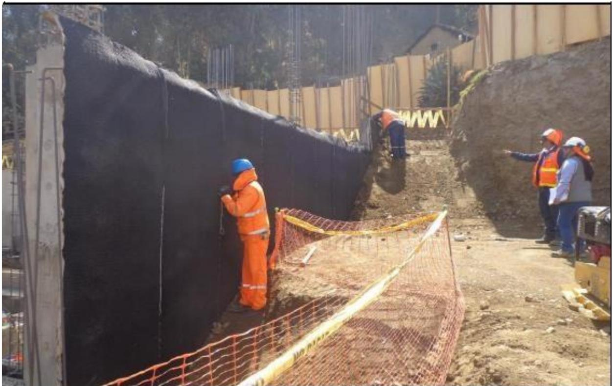
DESCRIPCIÓN: VERIFICACIÓN DE LA CORRECTA INSTALACIÓN DE LA GEOMEMBRANA EN EL MURO DE CONTENCIÓN M-1
