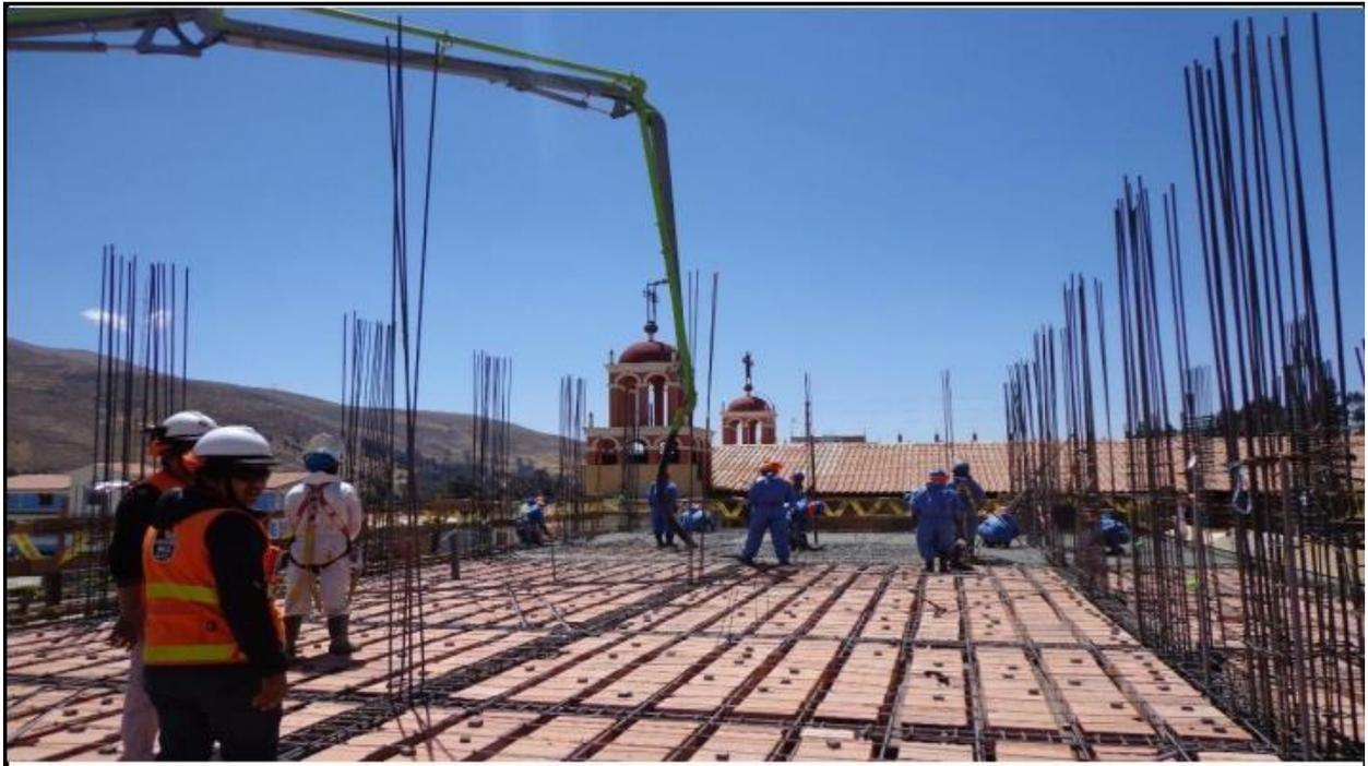
DESCRIPCIÓN: VERIFICACIÓN DEL VACIADO DE LOSA ALIGERADA DEL PABELLÓN 6.
