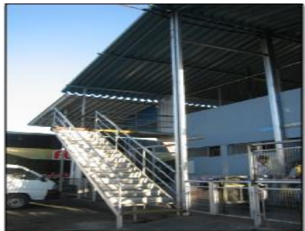
Imagen N° 8: Acceso segundo nivel oficinas administrativas
