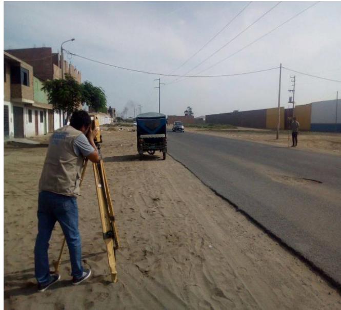
Foto N° 01: Realizando el levantamiento topográfico en el tramo Av.Camino Real y Calle Cajamarca.
