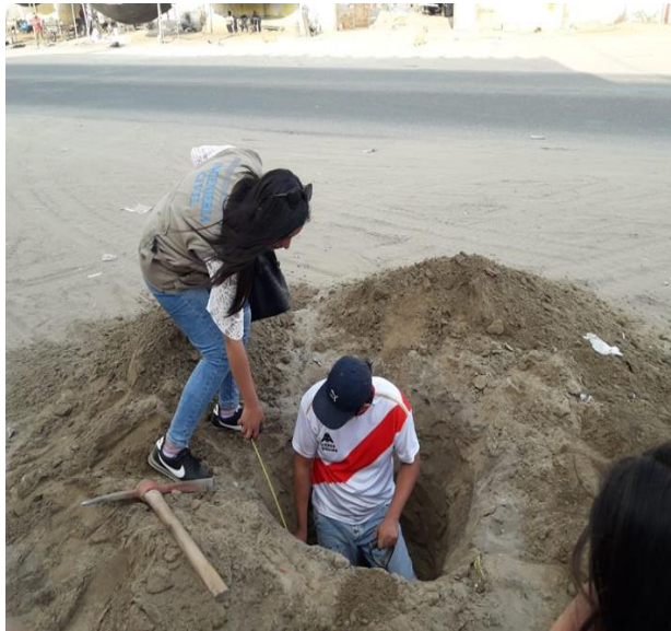
Foto N° 07: Excavación de la calicata C-1 en la progresiva 0+000
