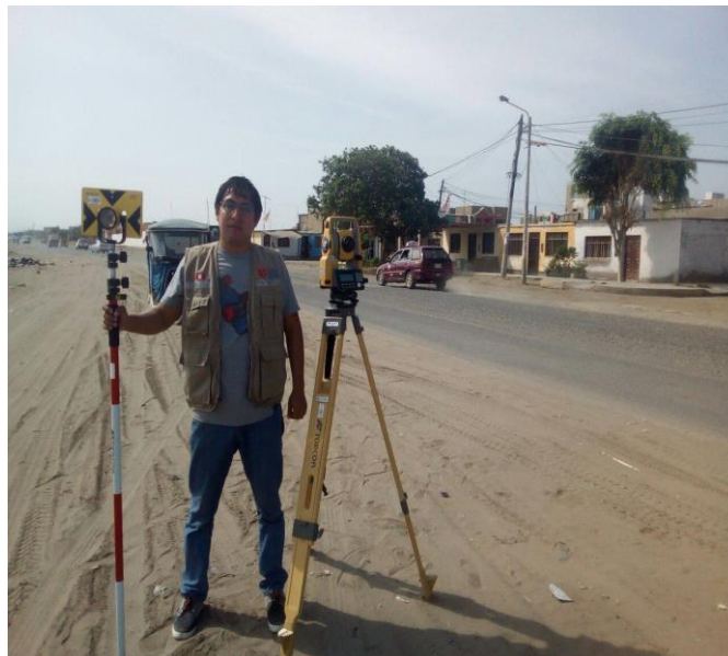
Foto N° 02: Utilizando el equipo completo para el levantamiento topográfico.
