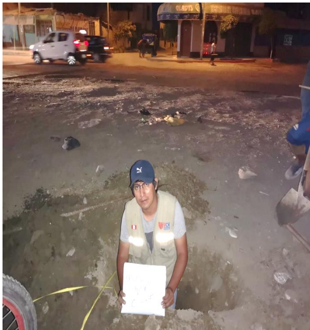
Foto N° 10: Excavación de la calicata C-4 en la progresiva 2+400
