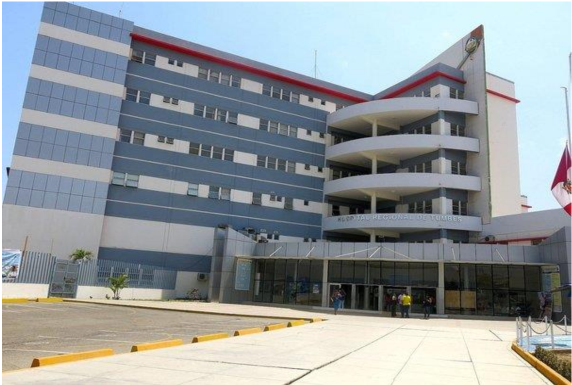
Figura 26. Hospital Regional de Tumbes. Recuperado de https://diariocorreo.pe/edicion/tumbes/evacuacion-total-del-hospital-regional-tras-el-inminente-colapso-de-su-infraestructura-706307/
