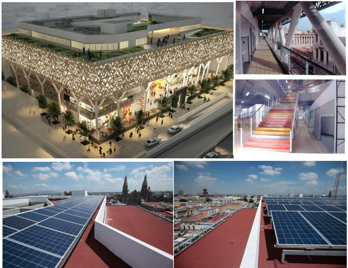
Figura 25. Paneles solares en Mercado Corona
