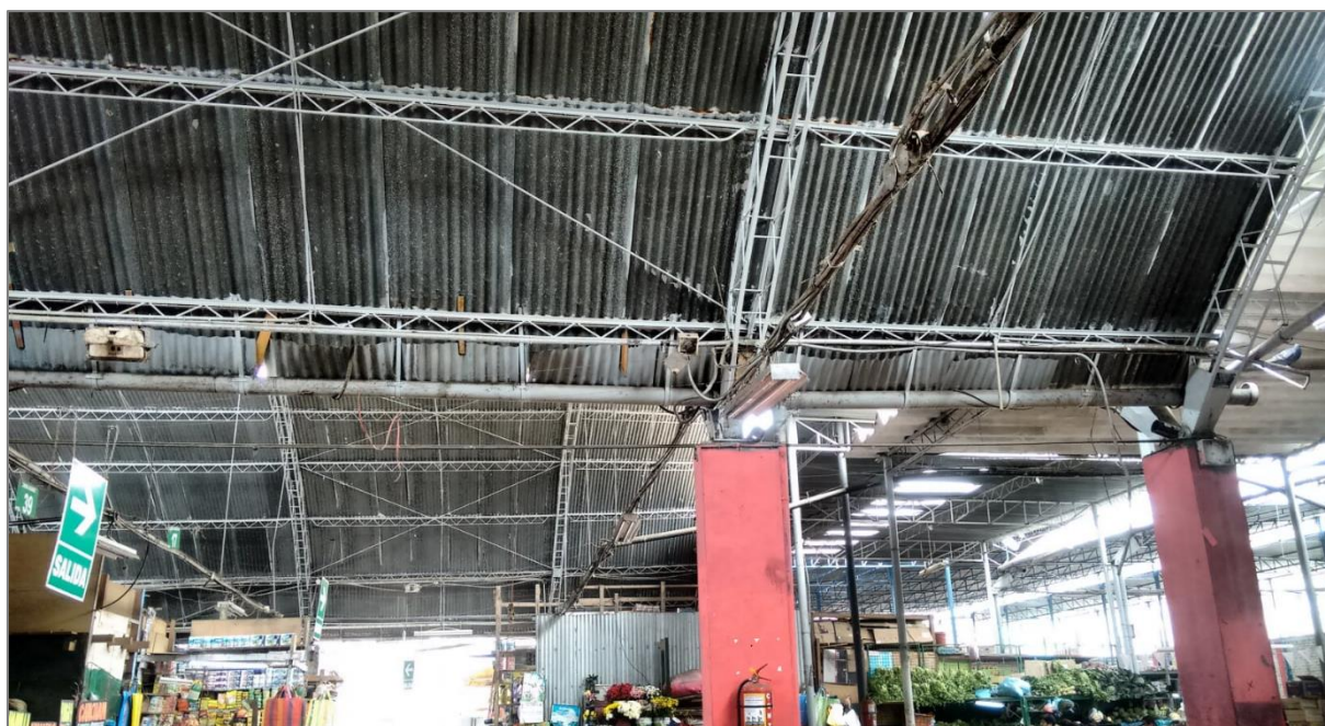
Figura 122. Vista de la cobertura e instalaciones
