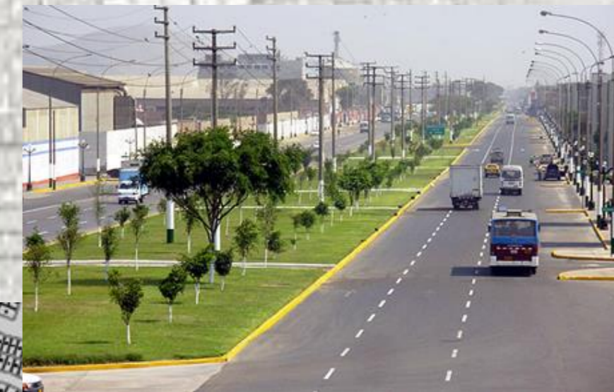
MEJORAMIENTO DE VÍAS, VEREDAS Y BERMAS
