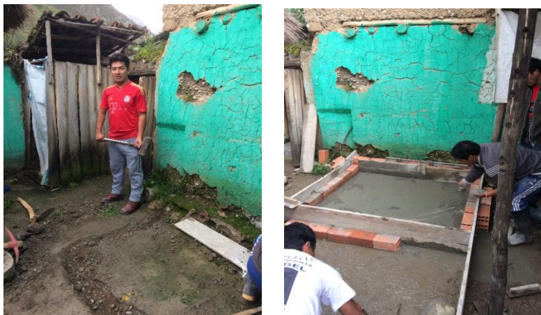
Figura N°06: Construcción de la base
