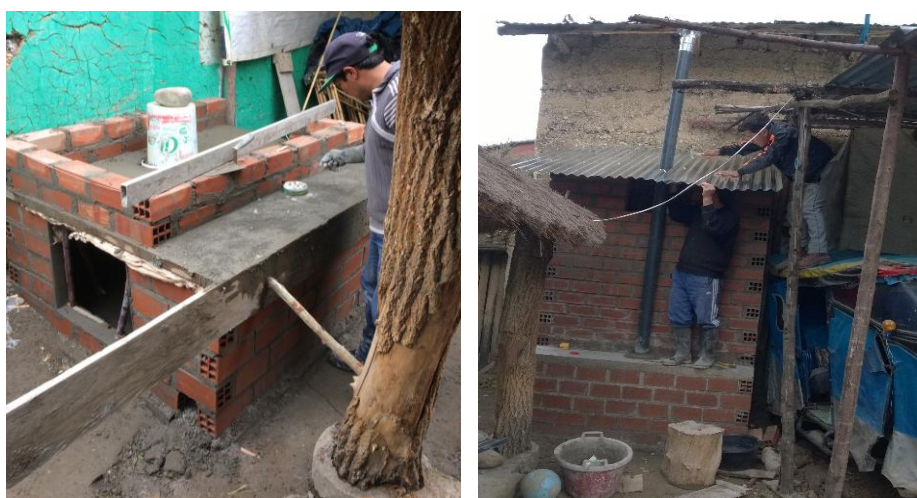
Figura N°10: Instalación de tuberías y pozo de absorción
