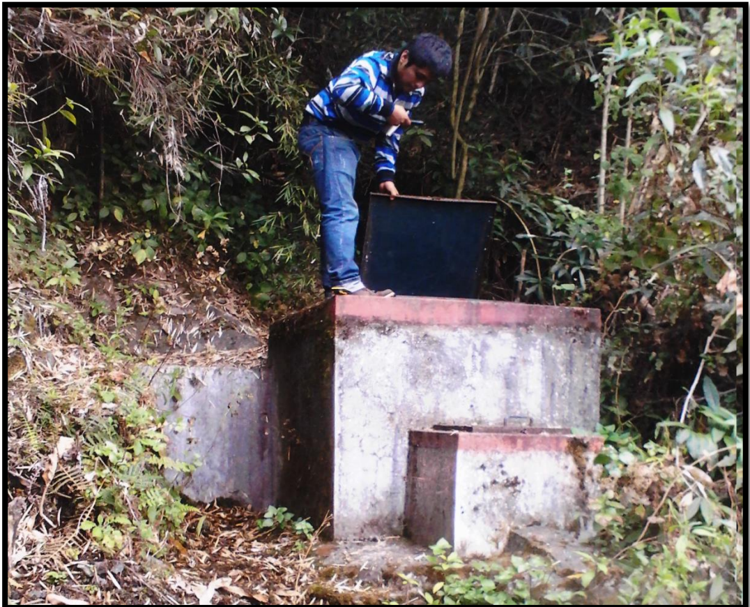
IMAGEN 4: CAPTACION EXISTENTE ALISO
