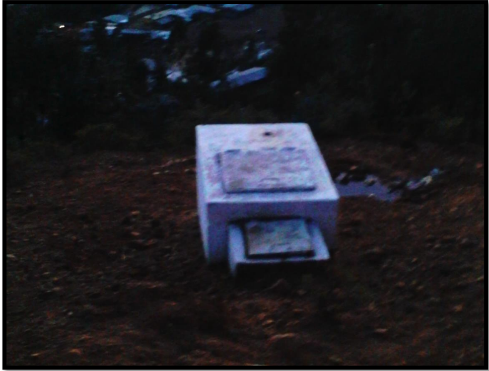
IMAGEN 3: CAMARA ROMPE PRESION EXISTENTE
