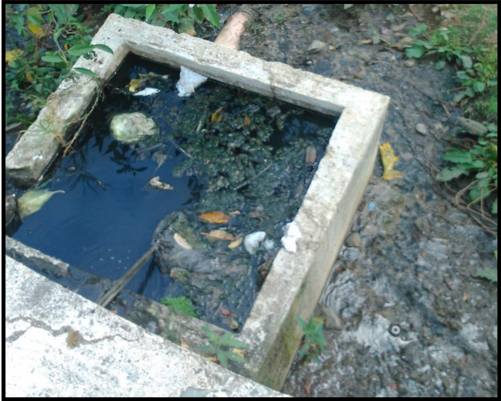
IMAGEN 5: ESTADO ACTUAL DE ESTRUCTURA EXISTENTE IX.
