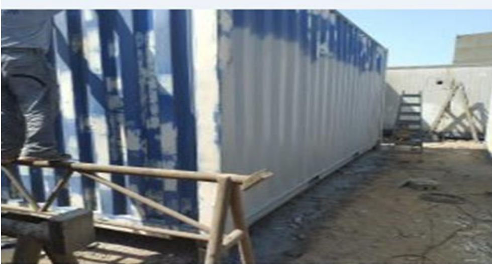
Figura 08: Zona de pintado de módulos prefabricados.
