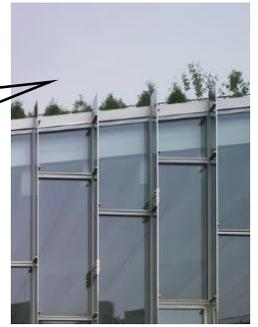
En las múltiples ocasiones en las que el edificio quiebra verticalmente, existen pequeños "sobrecimientos" en los cuales se insertan anexos del montante horizontal que se desprenden de la losa y/o viga.
