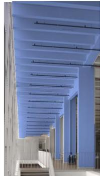
El sistema estructural se compone de el uso del pórtico de concreto, ya que la extensión y complejidad espacial que exige el proyecto merece este tipo de sistema por sus altísimas cargas, su carácter de edificio esencial y su aporte volumétrico espacial.
