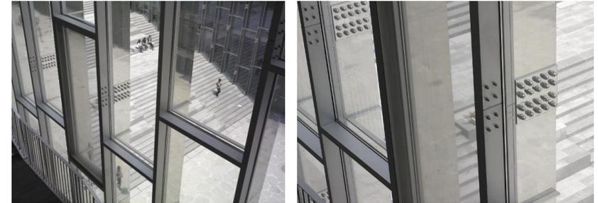
La estructura del montante principal de la transparencia, que es de una escala monumental, se enlaza a partir de estos empalmes emperrados, lo cual funciona de forma inteligente ya que no se parten en los nodos, sino en los tramos longitudinales.
