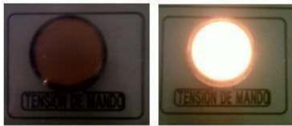
Focos de tensión de mando. Fuente: Adelte, 2013, p. 4
