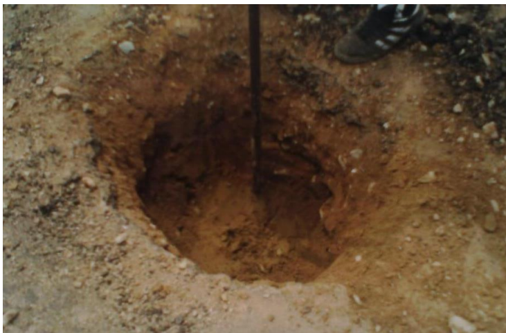
Figura 5. Excavación de la Calicata. Fuente: Elaboración Propia.
