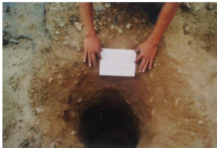
Figura 6. Se procedió a identificar la calicata como C1. Fuente: Elaboración Propia
