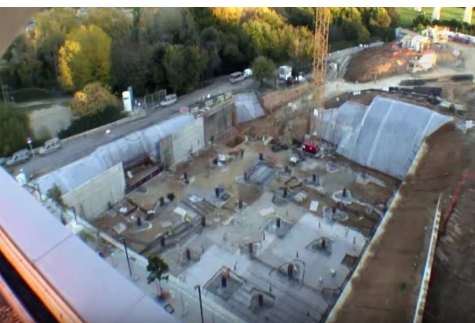
CONSTRUCCIÓN DE LOS DOS SÓTANOS
