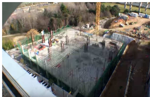
CONSTRUCCIÓN DE LOS ELEMENTOS VERTICALES Y HORIZONTALS SUPERIORES
